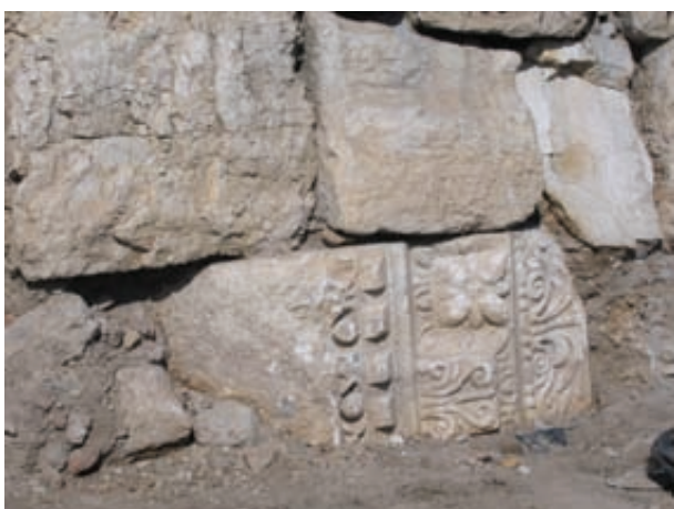
Elément de corniche antique remployé dans les fortifications, Bab Sharqi. Cliché J.-C. Bessac.
