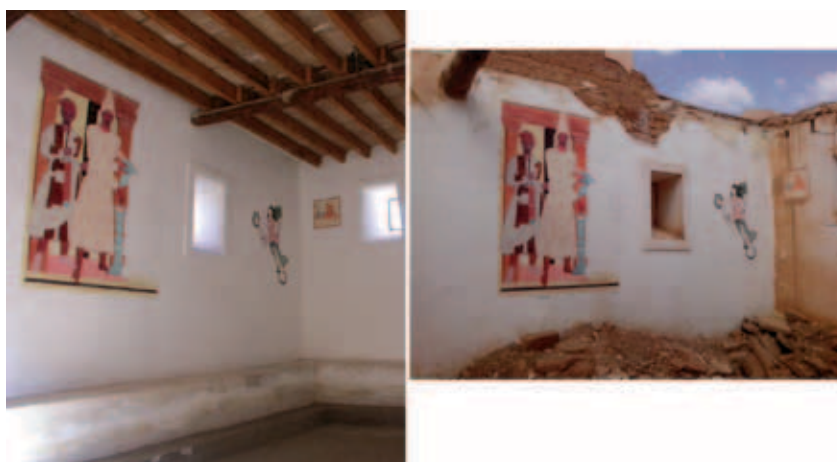
Fig. 8 : Pièce d'accueil du musée de site. À gauche en avril 2005, (source H. David-Cuny. À droite en avril 2013, © transféré à M. Gelin).
