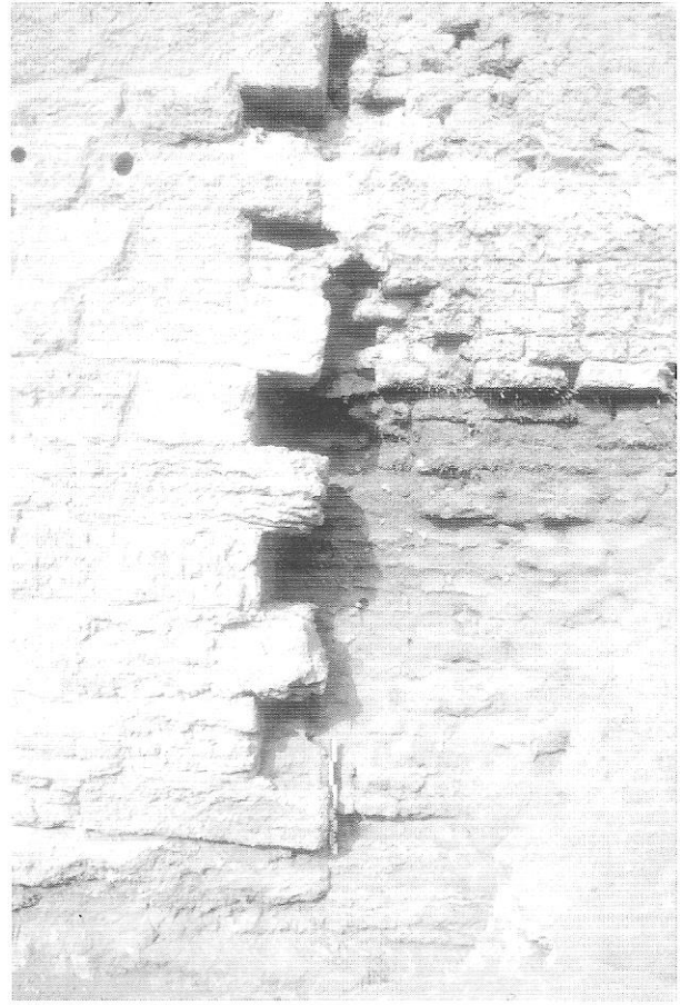
Fig. 27 - Détail de la maçonnerie du mur B3. La zone inférieure est humide, la zone supérieure ne l'est pas. Entre les deux, la couche supplémentaire.
