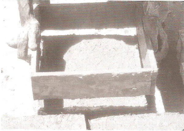
Fig. 6 – Moule à brique simple qui vient d'être retiré.
