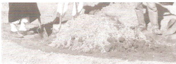
Fig. 5 – Matériaux destinés à la préparation du mélange pour la fabrication des briques : terre humide, paille.
