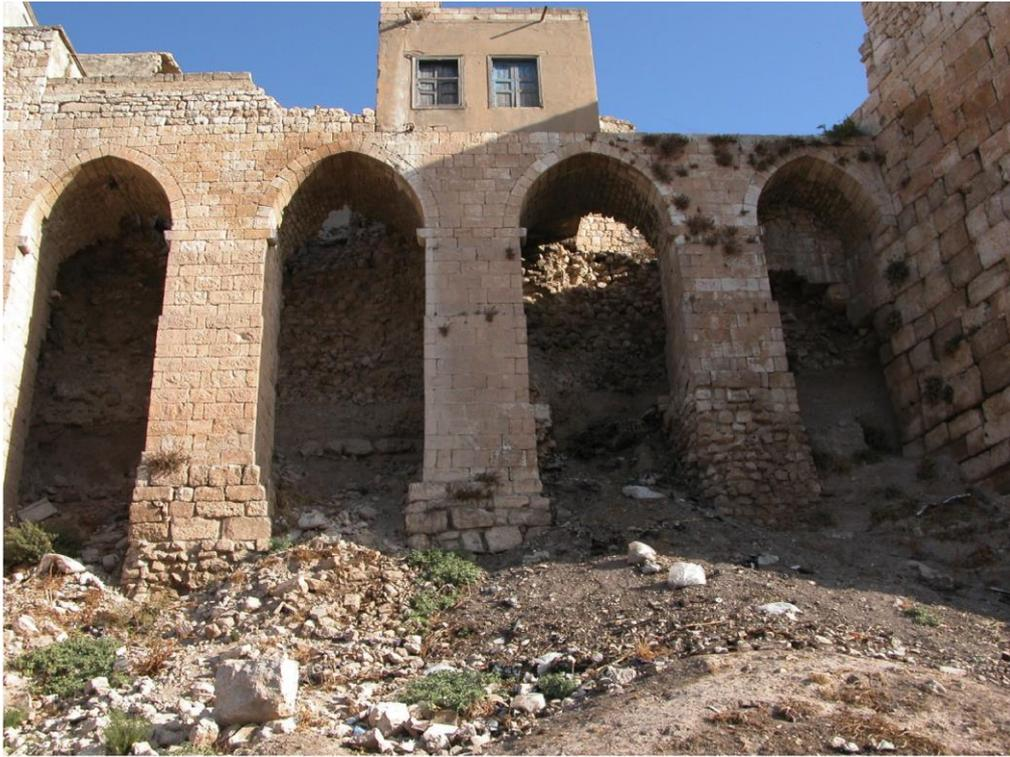
Fig. 9 : Secteur des contreforts. Entre les piliers, à la base, la masse de terre située sous la maçonnerie en moellons représente le rempart en briques crues.
