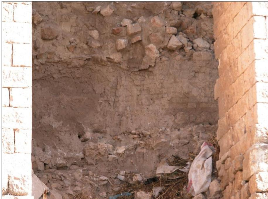
Fig. 10 : Détail du rempart en briques crues sous le premier arc des contreforts depuis l'ouest.
