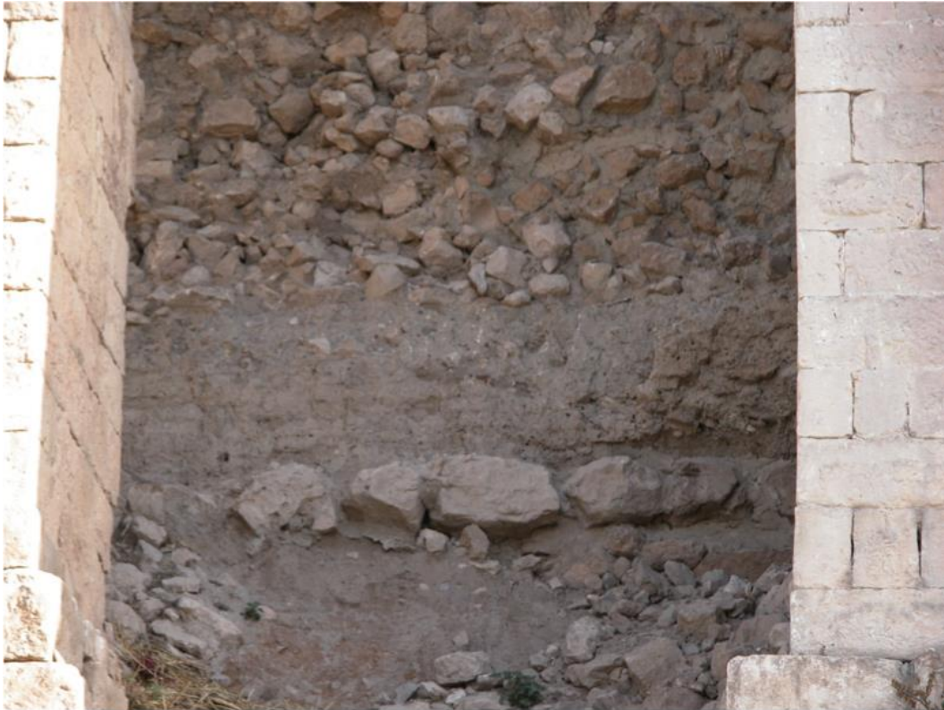
Fig. 11 : Détail du rempart en briques crues sous le deuxième arc des contreforts depuis l'ouest. La fondation en pierre est clairement visible. Vue vers le nord (MFSQM).
