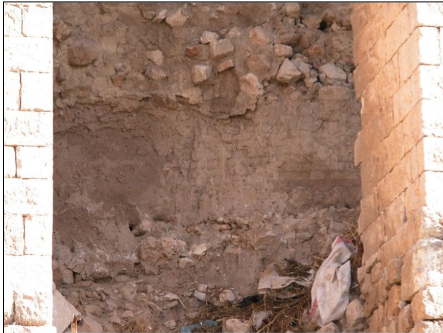
Fig. 10 : Détail du rempart en briques crues sous le premier arc des contreforts depuis l'ouest. Les briques se voient nettement sur la droite du cliché ; on devine un lit de pierres en-dessous. Vue vers le nord. (MFSQM).
