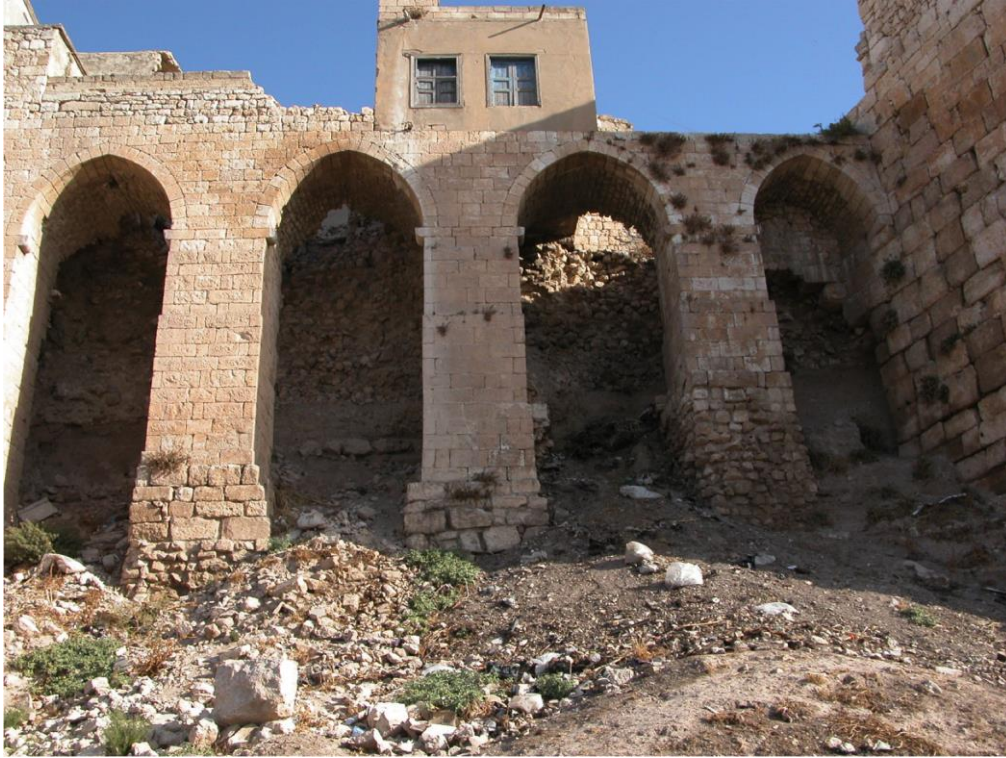
Fig. 9 : Secteur des contreforts. Entre les piliers, à la base, la masse de terre située sous la maçonnerie en moellons représente le rempart en briques crues. Vue vers le nord (MFSQM).
