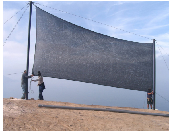
Figura 8. “Terminando de instalar un atrapanieblas de 40 m2 de malla raschel hacia los 800 msnm, en el oasis de niebla de Alto Patache, año 2007”. Fotografía de H. Larrain, Eco-antropología.blogspot.com
