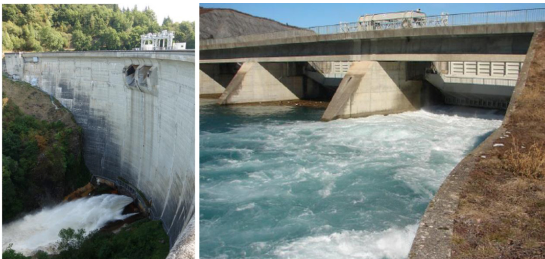
Fig. 7. Photographies de deux lâchers à vocation morphogène : (a) par la vanne de fond sur le barrage de Maury sur la Selves et (b) par les vannes de surface sur le barrage de la Saulce sur la Durance (EDF).
