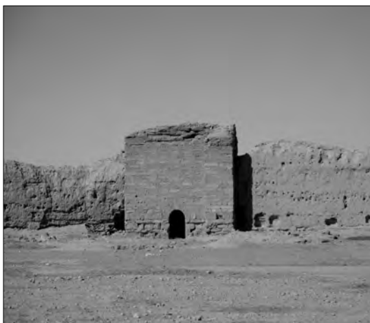
Fig. 4. La tour 24 en pierres, au centre des courtines en briques crues. Vue vers l'ouest.
