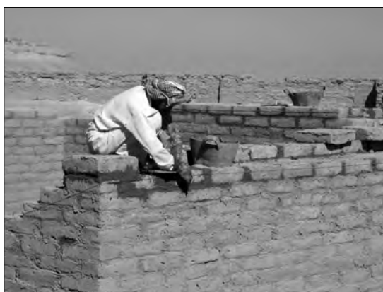
Fig. 13. Mise en œuvre des briques par un maçon, au cours de la reconstruction expérimentale d'une « maison romaine » (cliché E. Léna, MFSDE).
