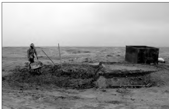
Fig. 10. Préparation de la terre à bâtir. Le mélange terre-paille-eau est prélevé pour la fabrication des briques. À droite, citerne d'eau et sac de paille (cliché MFSDE).
