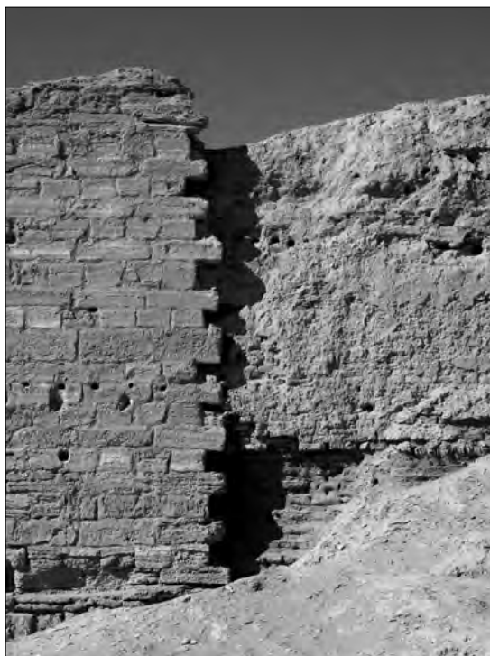
Fig. 8. Jonction entre la muraille occidentale de pierres de taille et de briques crues. Les briques sont celles d'origine (époque hellénistique).
