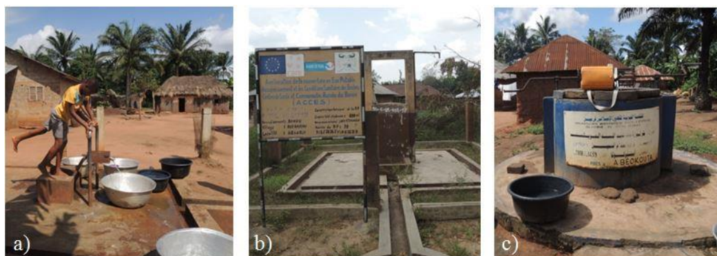
Figure 7 : Aperçu a) d'une pompe à motricité humaine, b) d'un forage profond, c) d'un puits à grand diamètre (photos personnelles Boccarossa A., 2019).
