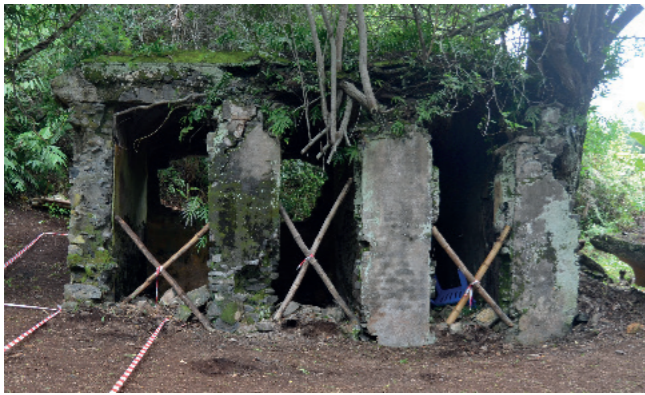
[Fig. 1]: Vue des vestiges en élévation des cachots, depuis le nord (photo M. Legros)
