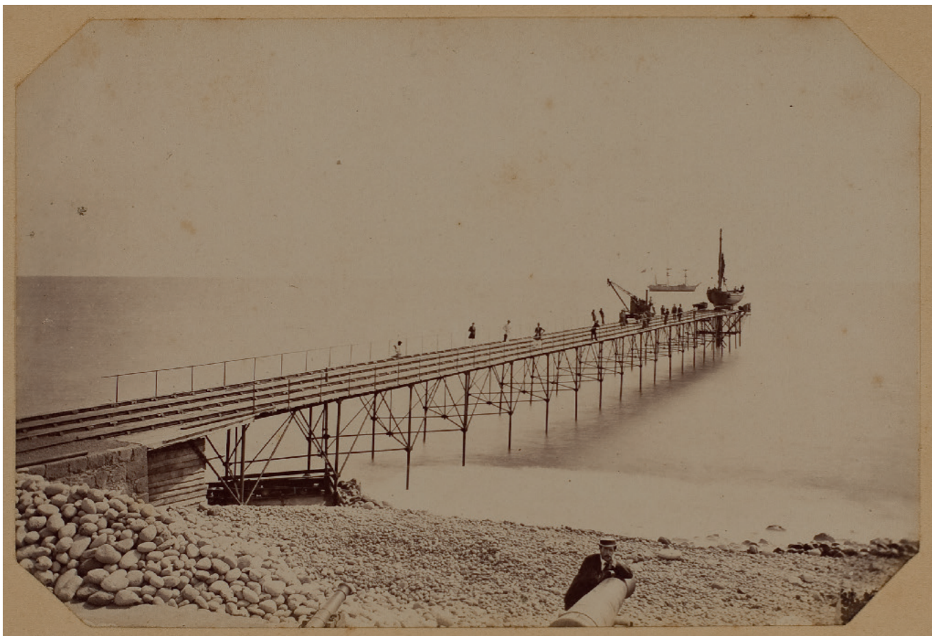
[Fig. 2]: Pont du butor à Saint-Denis : vue rapprochée. Charles Saunier (18.-19..) - 1870 ?. Photographie. Bibliothèque départementale de La Réunion - FRB974115201_R00267.006_1. Iconothèque historique de l'océan Indien
