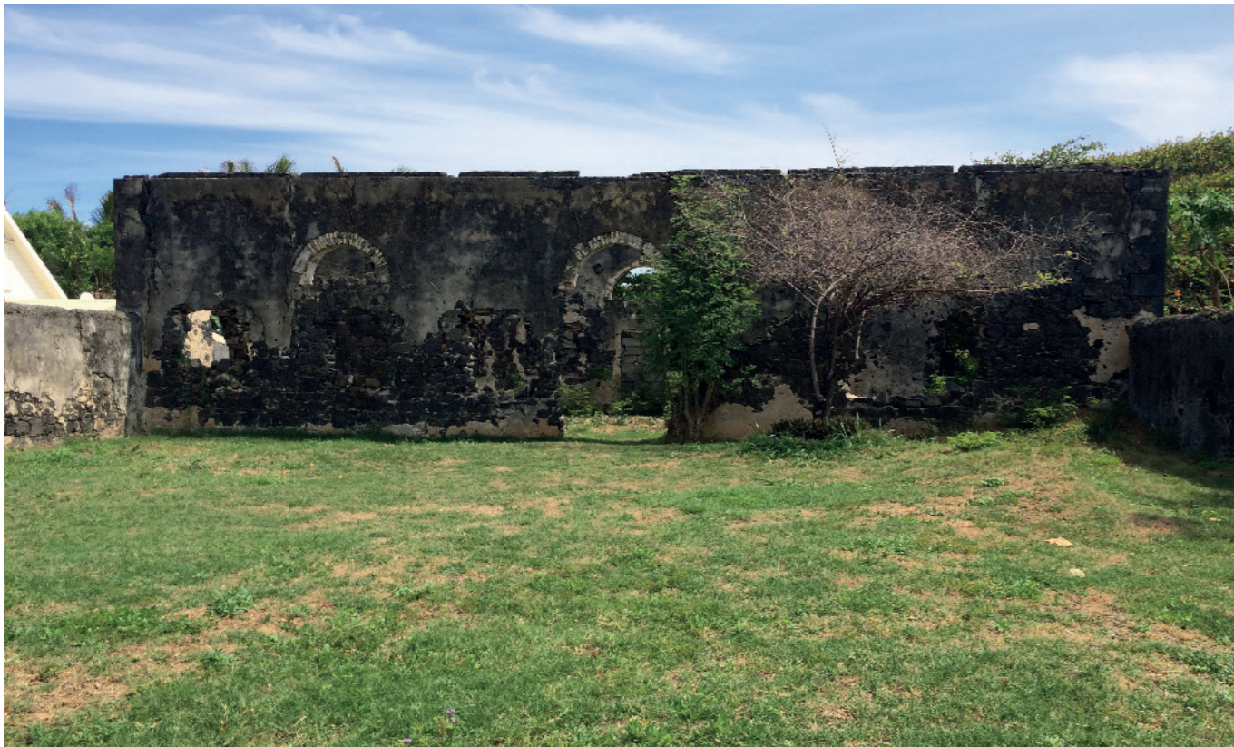
[Fig. 2]: Vue de la façade nord du bâtiment 1 (photo Th. Cornec / Inrap)
