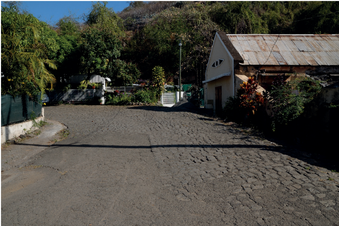
[Fig. 4]: Vue du chemin, dans l'impasse dite « du pied des Rampes » (photo P. Brial)
