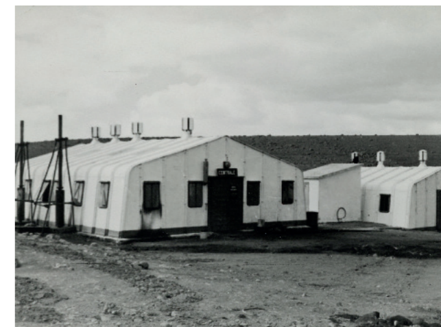
[Fig. 1]: Kerguelen, Port-aux-Français, Bâtiment de type Fillod habitant l'ancienne centrale électrique, sans auteur, 1950, archipèle, IPEV cote 1 KER 1233
