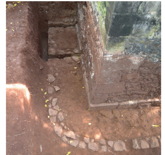
[Fig. 6]: Vue du système d'évacuation des eaux usées à l'extérieur du bâtiment, depuis l'est (photo M. Legros)
