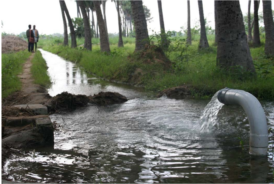
Photo 4.5 : L'un des exutoires d'un forage, à quelques mètres du forage lui-même. Tout un réseau enterré de tuyaux permet au propriétaire du forage d'apporter l'eau en différents points de sa propriété. Cela ne l'empêche pas de devoir souvent utiliser les canaux par la suite pour accéder à la parcelle à irriguer. (Photo : O. Aubriot, Tamil Nadu 2006)
