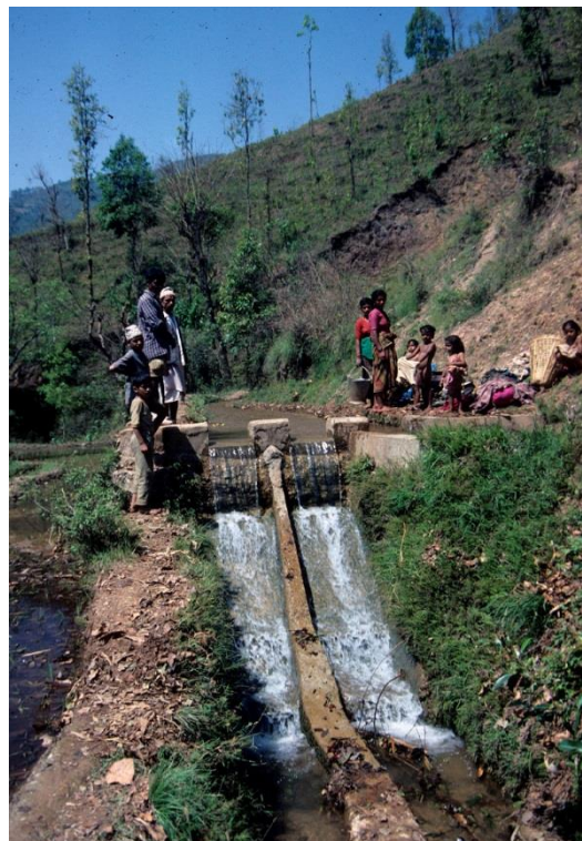
Photo A2.1 : Le partiteur d'Aslewacaur sur le canal principal, ici en période sèche où peu d'eau s'écoule dans le canal (Cliché O. Aubriot, avril 1990)
