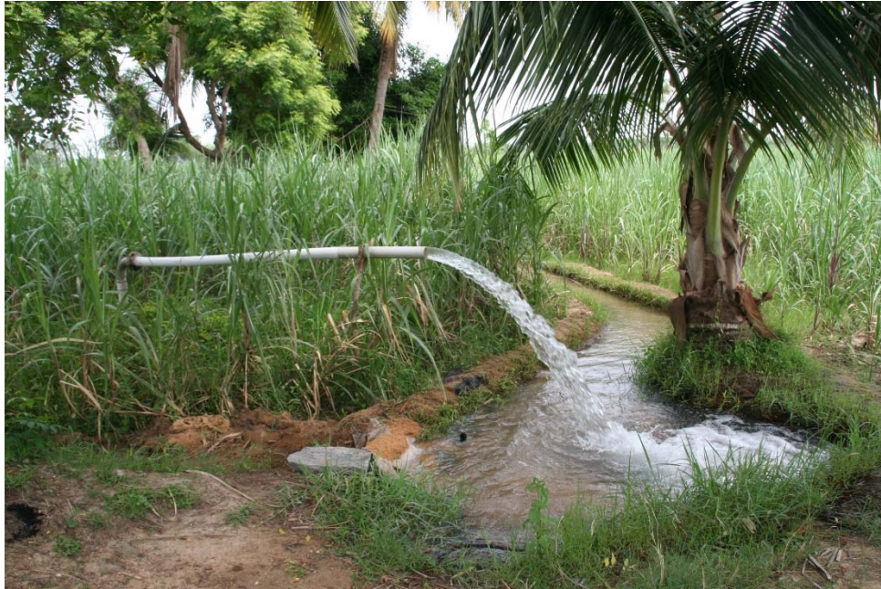
Photo 4.4 : Partie visible (exutoire) d'un forage avec pompe submersible ( tubewell ).
