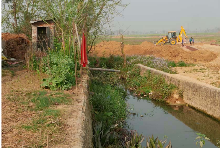
Photo 4.8 : Le trop-plein des toilettes est prévu pour se déverser dans le canal principal. En arrière-plan, une pelleuse aplanit les limites de parcelles agricoles pour créer une zone de lotissements.
