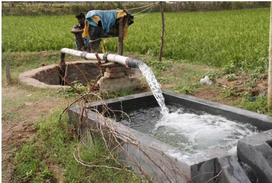
Photo 4.3 : Puits tubé ( well-cum-bore ) en zone alluviale, avec le moteur à l'extérieur (sous les bâches).
