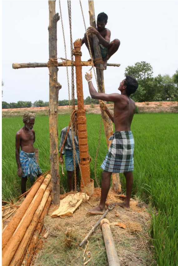
Photo 4.6 : Extraction d'une pompe submersible afin de la réparer (Photo : O. Aubriot, Pondichéry, 2006)
