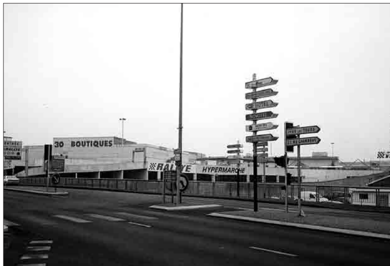
Entrée Sud de Tours. Centre commercial années 70.
