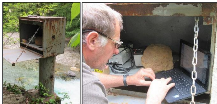
FIG.4 — Puits du limnigraphe sur le Galeizon à l'Aube morte, abritant l'équipement de mesure Solophème (gauche) ; sonde dans le puits du limnigraphe, centrale Solophème et récupération du fichier de données (droite)
