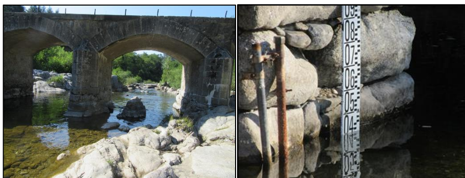
FIG.44 — STATION DE SAINT-JEAN DU GARD - À GAUCHE, GARDON DE SAINT-JEAN AU PONT DE CAMBONÉRAL, VU DE L'AMONT — À DROITE, ÉCHELLE AU PLUS BAS DE L'ÉTIAGE, LE 9 SEPTEMBRE 2019
