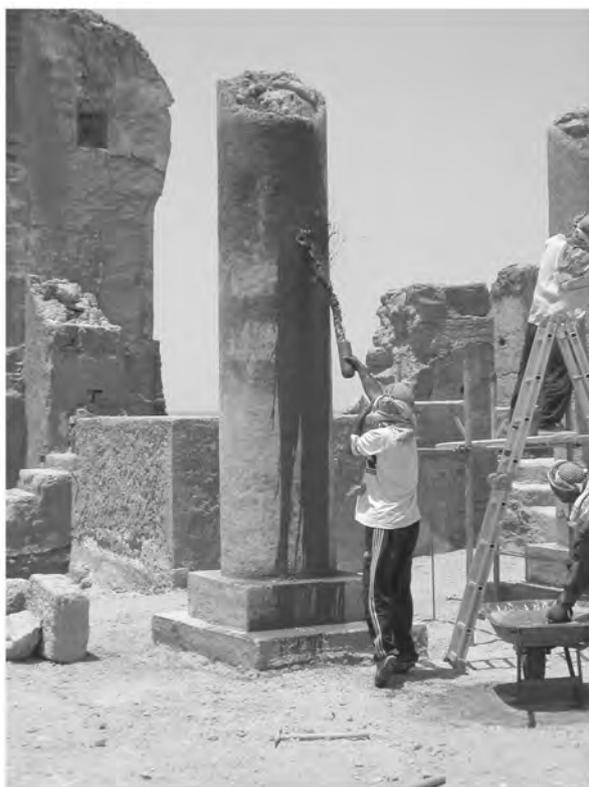
Fig. 13. Doura-Europos, sanctuaire de Bêl. Patinage d'une colonne en *djousse* du portique ouest, au moyen de boue. Le mur situé immédiatement derrière est patiné, celui en arrière-plan est d'origine. Photo M. Gelin, MFSDE.
