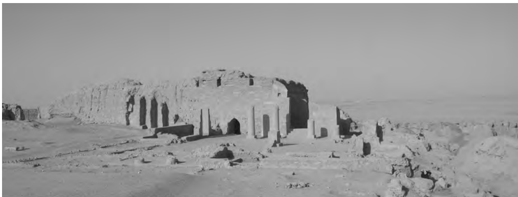
Fig. 5 A Doura-Europos, sanctuaire de Bêl. État de l'édifice avant les travaux en 2002 et après restauration (état en 2004). Vue vers l'ouest. Photo M. Gelin, MFSDE.
