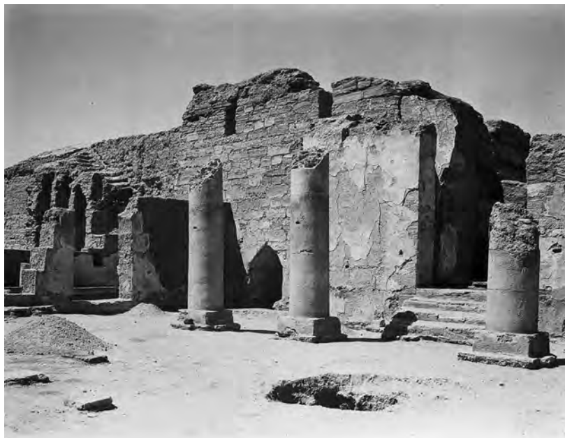
Fig. 7. Doura-Europos, sanctuaire de Bêl. Vue du portique ouest peu après son dégagement dans les années 1930. Vue vers le sud-ouest. Archive Yale University.
