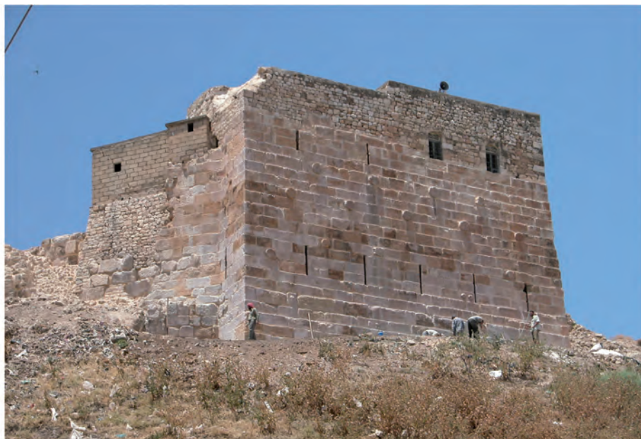
Fig. 3: Qalaat el Moudiq, façade orientale consolidée de la tour médiévale, vue vers l'ouest. Mission franco-syrienne de Qalaat el Moudiq.
