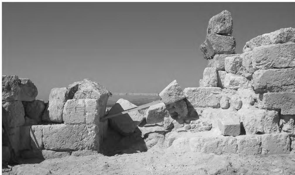
Fig. 4. Cyrrhus, tour médiévale n°3 de la citadelle. Les montants de la porte, ici avant travaux, ont été consolidés au moment même de leur dégagement et restitués avec les blocs d'origine, tombés sur place. Photo M. Gelin, © Mission libano-syrienne de Cyrrhus-Nebi Hourri.
