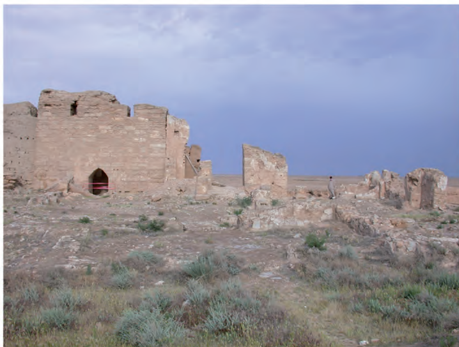
Fig. 5 B: Doura-Europos, sanctuaire de Bél. État de l'édifice avant les travaux en 2002 et après restauration (état en 2004). Vue vers l'ouest. Photo M. Gelin, MFSDE.
