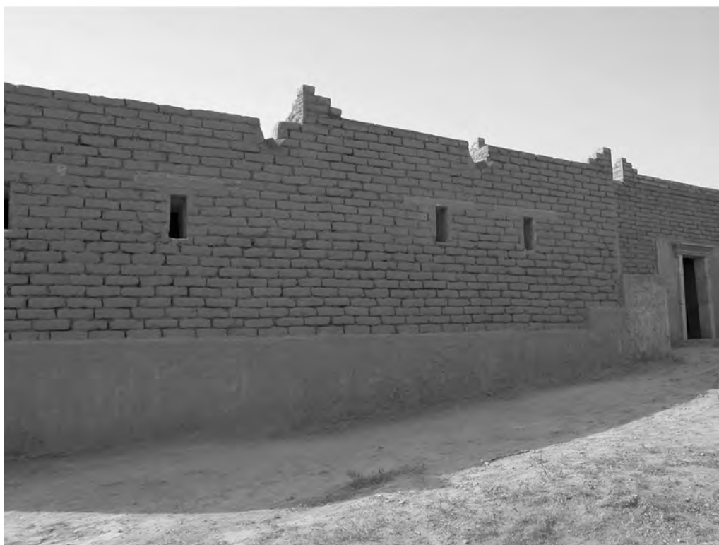
Fig. 6. Doura-Europos, "maison romaine". Élévation restituée de la façade nord, avant la pose de l'enduit. Vue vers le sud-ouest. Photo É. Léna, MFSDE.
