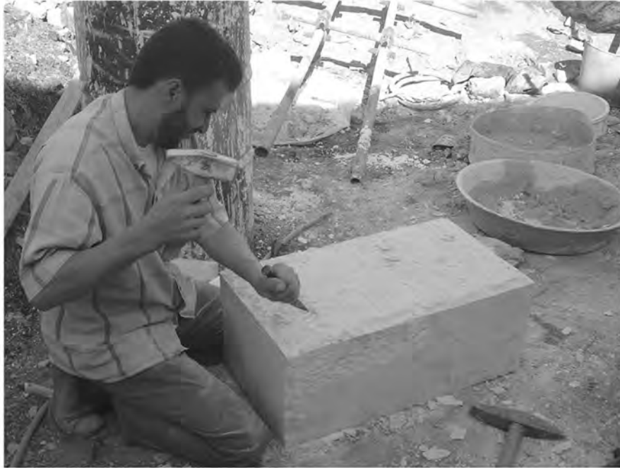
Fig. 14. Qalaat el Moudiq, taillage de surface d'un bloc scié afin de "vieillir" le parement. © Mission franco-syrienne de Qalaat el Moudiq.
