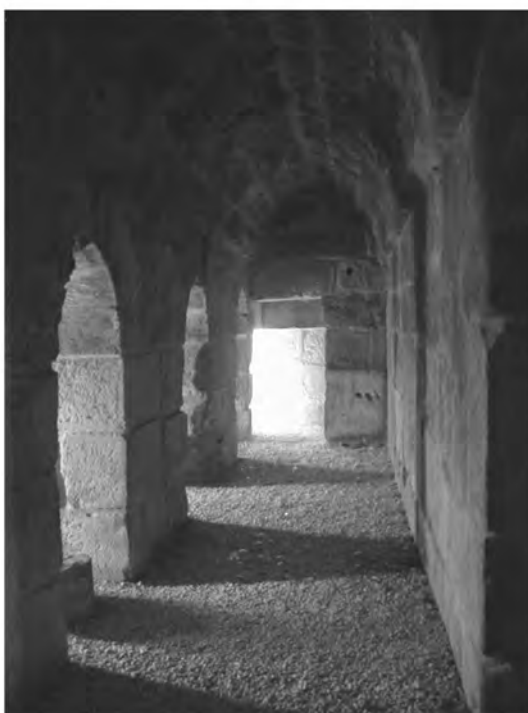
Fig. 16 A et B. Qalaat el Moudiq, la galerie orientale avant et après travaux de la tour médiévale, en vue de sa présentation. © Mission franco-syrienne de Qalaat el Moudiq
