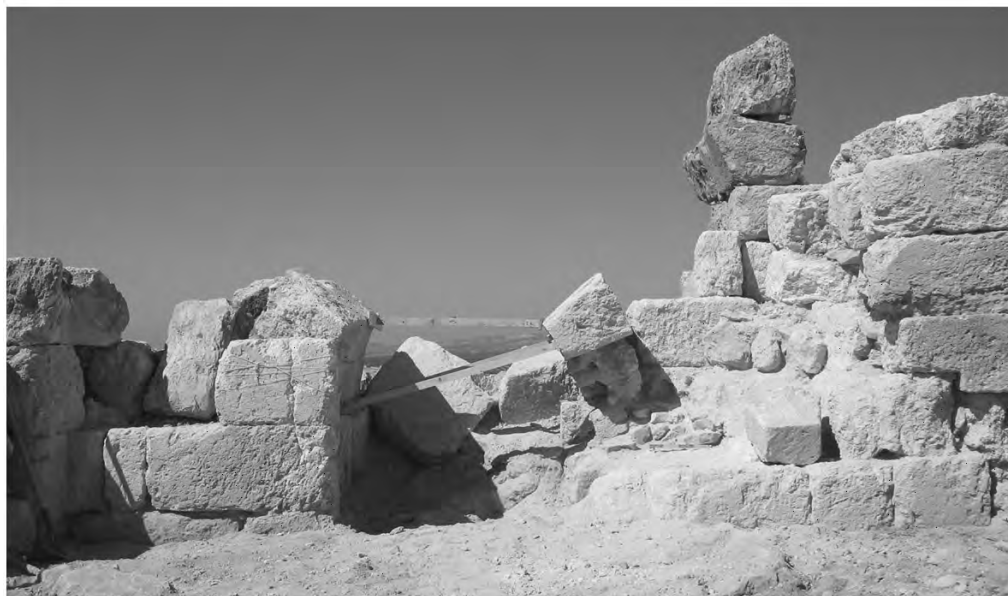
Fig. 4. Cyrrhus, tour médiévale n°3 de la citadelle. Les montants de la porte, ici avant travaux, ont été consolidés au moment même de leur dégagement et restitués avec les blocs d'origine, tombés sur place. Photo M. Gelin, © Mission libano-syrienne de Cyrrhus-Nebi Hourri.
