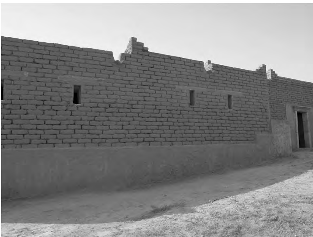
Fig. 6. Doura-Europos, "maison romaine". Élévation restituée de la façade nord, avant la pose de l'enduit. Vue vers le sud-ouest. Photo É. Léna, MFSDE.
