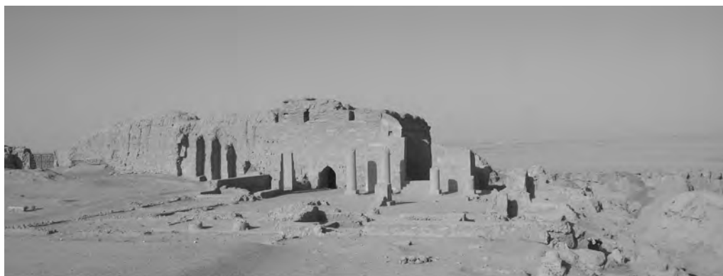
Fig. 5 A Doura-Europos, sanctuaire de Bêl. État de l'édifice avant les travaux en 2002 et après restauration (état en 2004). Vue vers l'ouest. Photo M. Gelin, MFSDE.
