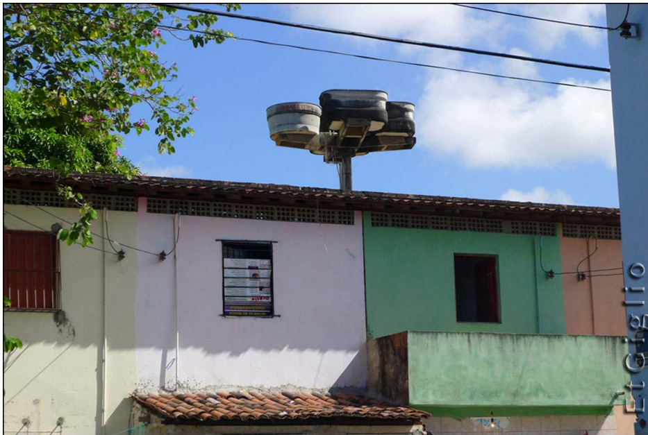
Photo 6. Citernes de toit à Campina do Barreto
