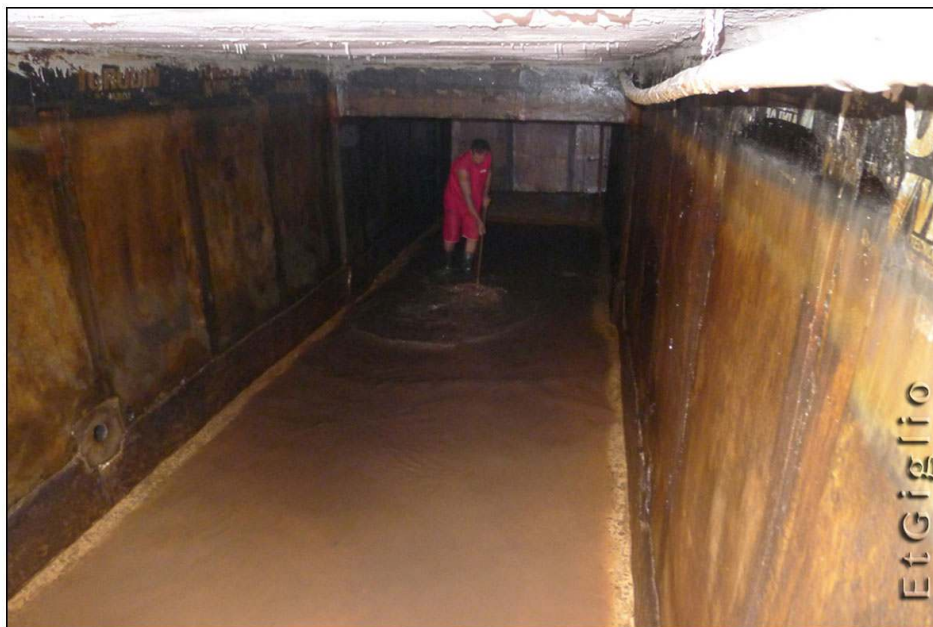
Photo 7. Citerne souterraine d'immeuble vidée pour son nettoyage à Pina
