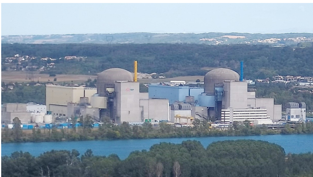
La centrale nucléaire de Saint-Alban
