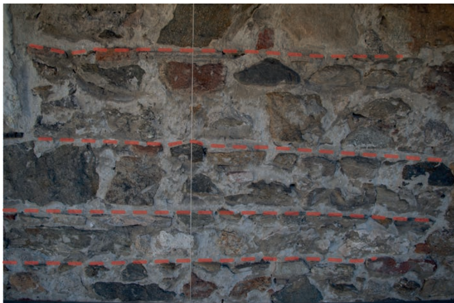
III. 34 : Vue de la maçonnerie UC 1.2 entre les baies B.6 et B.7 avec indication des planées de travail; Cliché : Quentin Rochet
