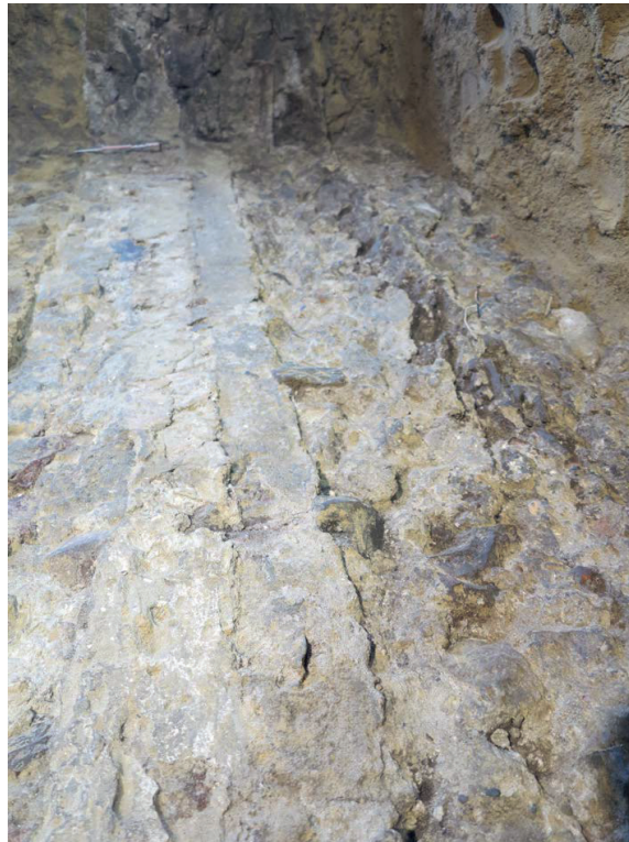
Vue des vestiges des différents niveaux de circulation dans le mur de chevet (UM 2). Piqéage de terre entre les niveaux de mortier (en bas, zone marron) et bandeaux d'enduit marquant un niveau de circulation une vingtaine de centimètres plus haut.
