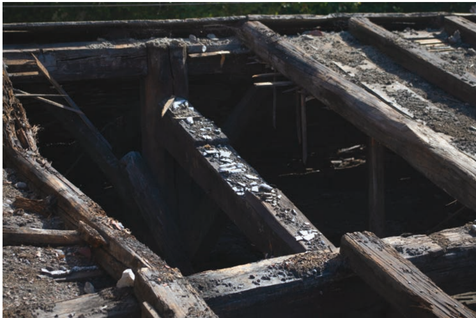
III. 07 : Dépose de la charpente et apparition d'une pièce en emploi comme arbalétrier, cliché : Quentin Rochet
