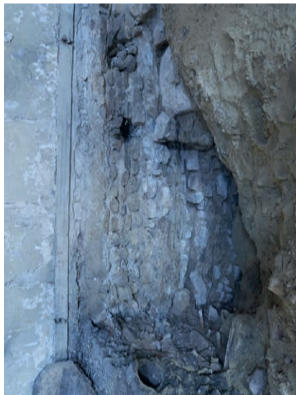
Elevation du mur nord (UM3) en partie basse: installation du mur actuel (période contemporaine) sur des maçonneries anciennes : massif de l'épaulement de la droite du cliché
