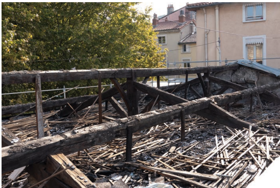
Ill. 20 : Charpente du XIX-XX e siècles, vue d'ensemble après dépose de la couverture ; Emilien Bouticourt
