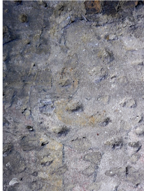
Mur est (UM2), partie sud - premier décor peint Détail au centre, vestiges de l'auréole blanche et de la chevelure jaune du Christ, devant la croix (bande horizontale jaune à gauche du cliché)
