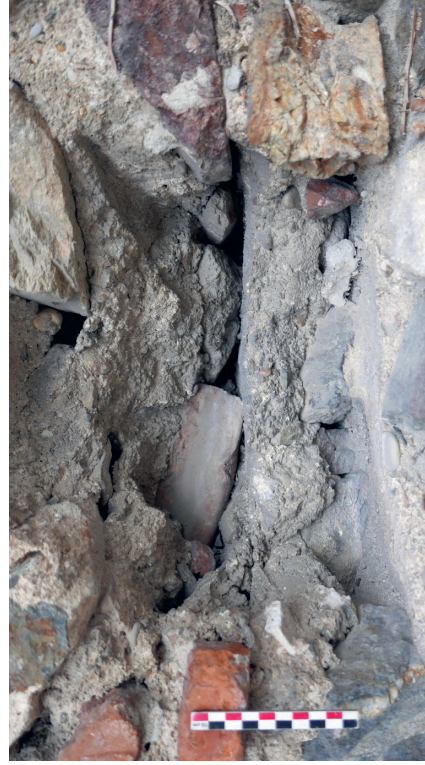
« planées » visible dans la maçonnerie de la deuxième phase dite carolingienne. Le niveau de mortier horizontal visible au centre de la photographie correspond à une phase de travail, peut-être une journée, au sein d'un même chantier de construction.
