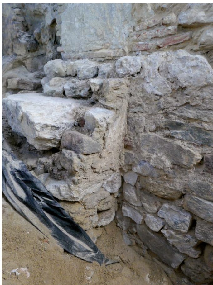
Ill. 09 : vue de l'angle formé par le développement de l'abside UC 1.43 (g.) et le mur gouttereau UC 1.42 (d.), cliché : David Jouneau
