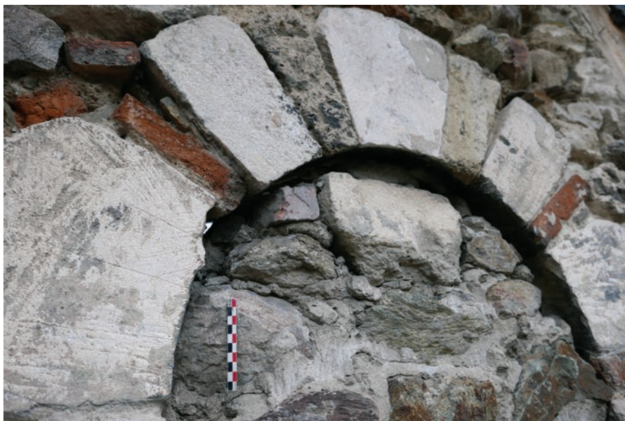
III. 14 : Détail de l'arc de la baie B.3 UC 1.1; Cliché : Quentin Rochet
