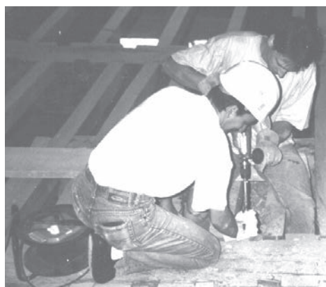
Photo 1 (Lavier) : Prélèvement à la tarière électrique
