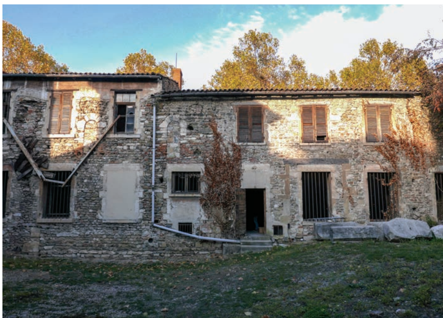
III. 01 : Vue du mur gouttereau sud de Saint-Georges (UM 1), vue depuis le Sud en amont de l'opération, photographie : Marie-Caroline Kurzaj
