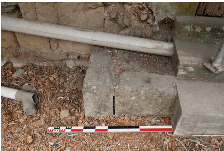
III. 11 : Vue du contrefort arasé au pied de l'UC 1.1; Cliché : Quentin Rochet
