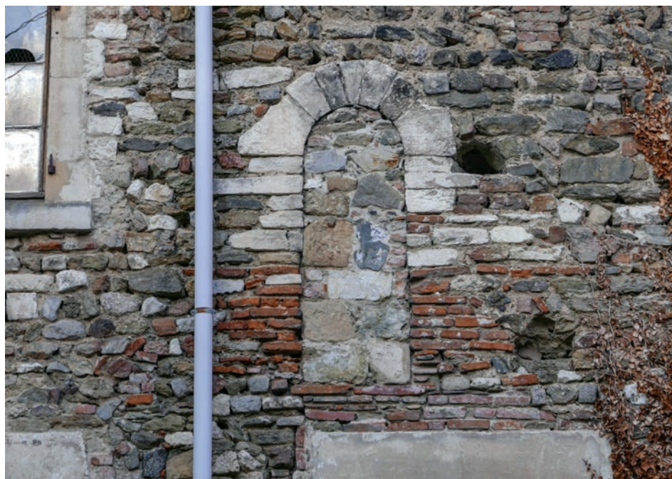
III. 13 : Baie B.5 en amont de l'opération archéologique ; Cliché : Marie-Caroline Kurzaj
