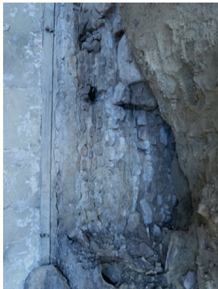
Elevation du mur nord (UM3) en partie basse: installation du mur actuel (période contemporaine) sur des maçonneries anciennes : massif de l'épaulement de l'abside (à droite du cliché)
