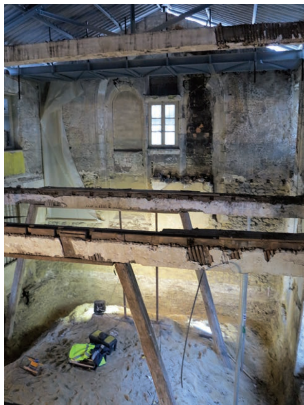
III. 17 : Vue d'ensemble du mur de chevet UM 2 durant l'opération; Cliché : Quentin Rochet
