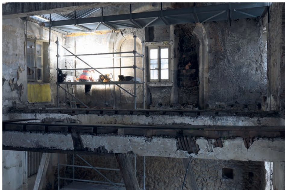
III. 06 : Relevé en cours des peintures du mur de chevet, cliché : Émilien Bouticourt
