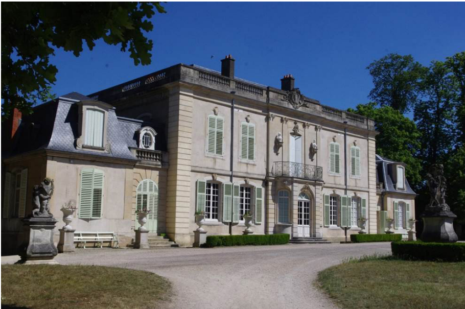
Fig. 1. Façade occidentale ouverte sur le parc , Laneuveville-devant-Nancy, château de Montaigu [© Isabelle Mangeot, 2016]
