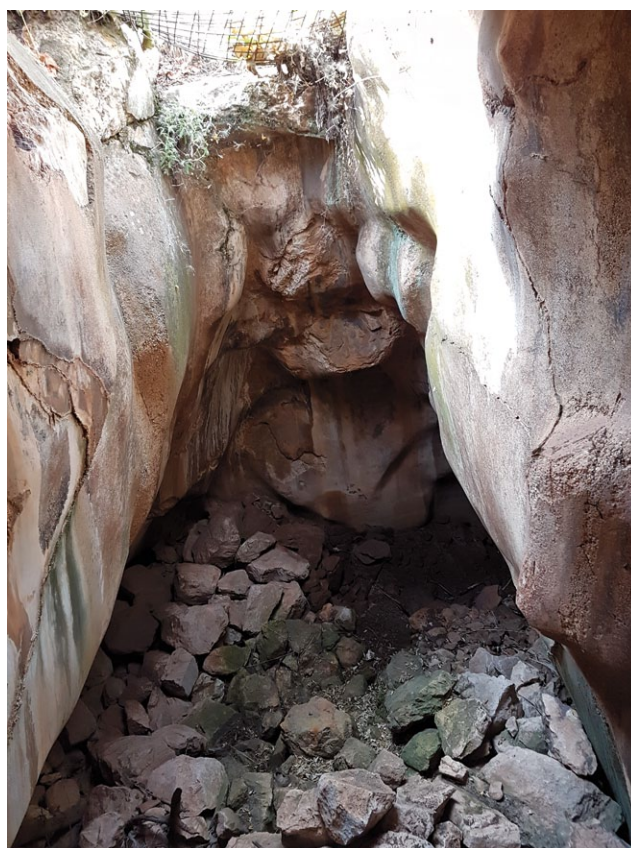
9. Medeon. Interno della cisterna n. 2 (foto di G. Polizzi)
