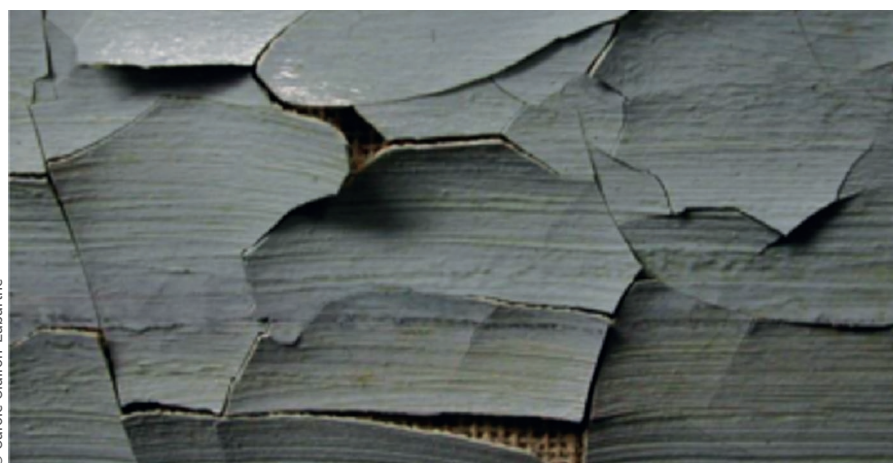
6. Décollement partiel d'une couche picturale du support.
