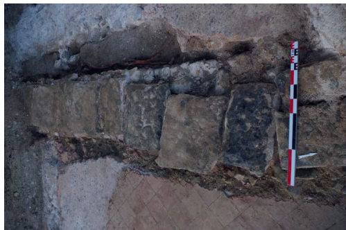
Le second collecteur (nord-sud) dans le secteur 2
