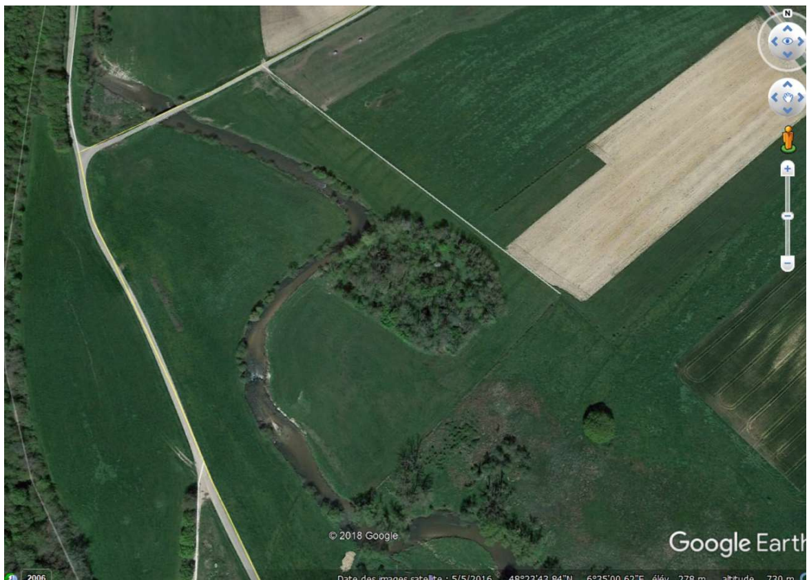
Figure III-9 : Sur cette vue de la section au nord de Roville-aux-Chênes, on peut observer trois seuils destinés à faciliter la manœuvre des trains de planches sur la Mortagne. Source : Image Google Earth.
