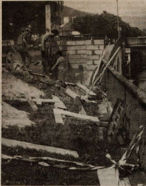
On construit l'abri.
