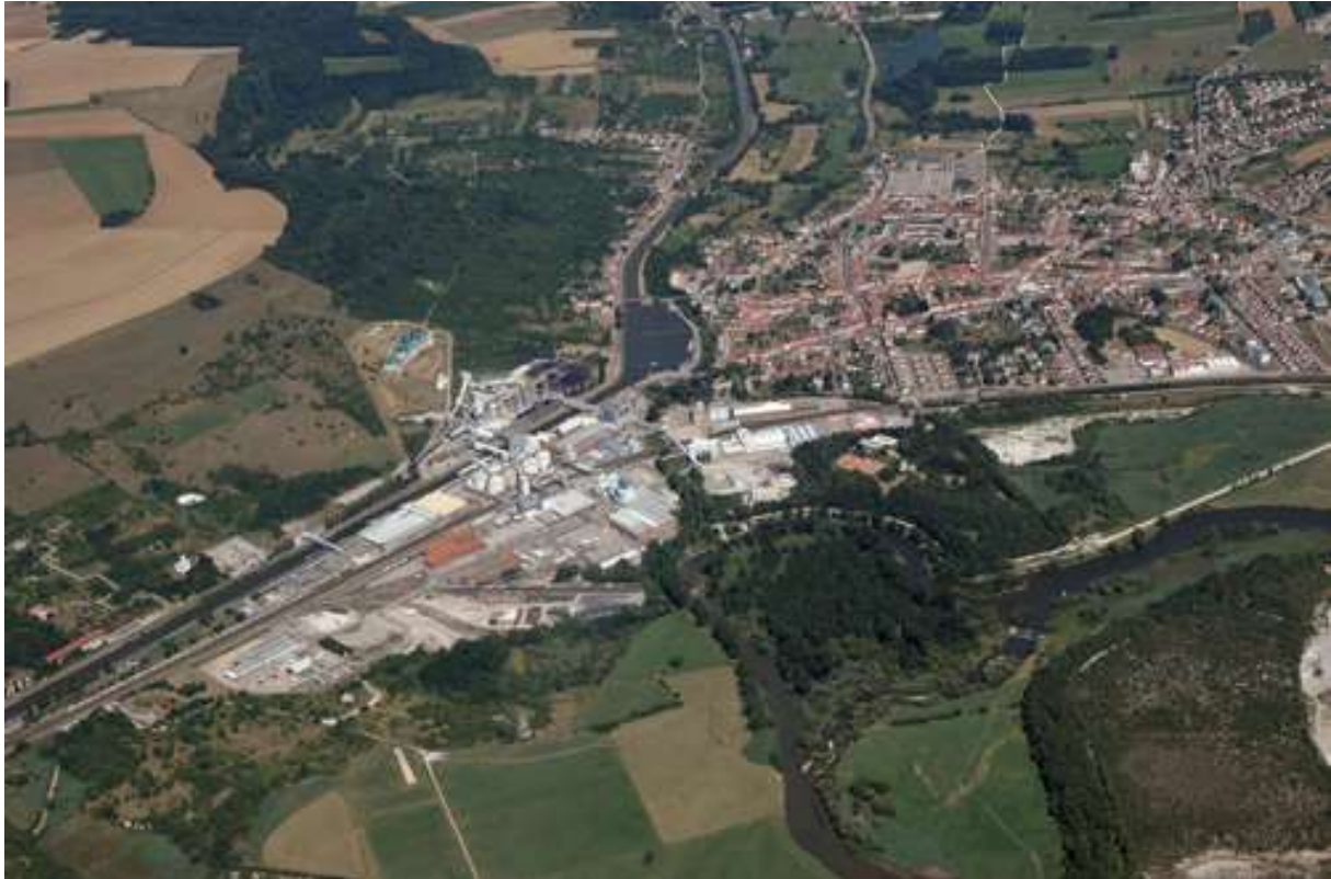
L'usine tourne le dos à la Meurthe. Elle est centrée sur le canal et la vallée du Sânon et tourne le dos à la Meurthe. Sa confluence avec la Meurthe, le Sânon traverse le site de l'usine et rejoint l'ancien méandre rectifié au XIXème siècle. Source CERPA/A. Humbert - Référence : 06-0170
