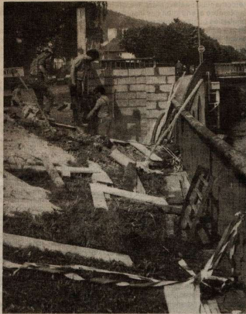
On construit l'abri.
