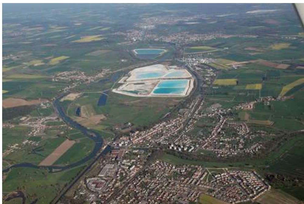
Photographie III-18 : Les bassins de décantation en amont de Dombasle. Source : photographie CERPA/A. Humbert
