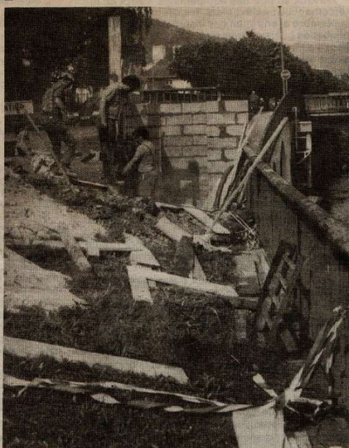
On construit l'abri.
