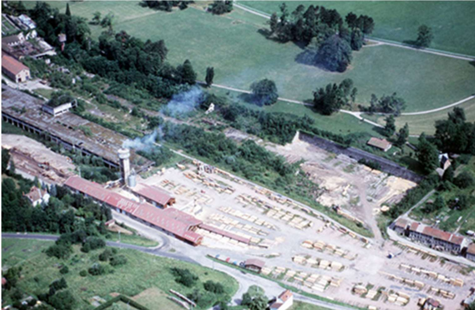
Photographie III-4 : Une scierie industrielle à Cirey-sur-Vezouze : Le parc à planches d'une surface conséquente témoigne encore d'une activité importante de la commune de Cirey-sur-Vezouze, le site avec ces friches montrent également le déclin de cette activité. Photographie CERPA/A. Humbert
