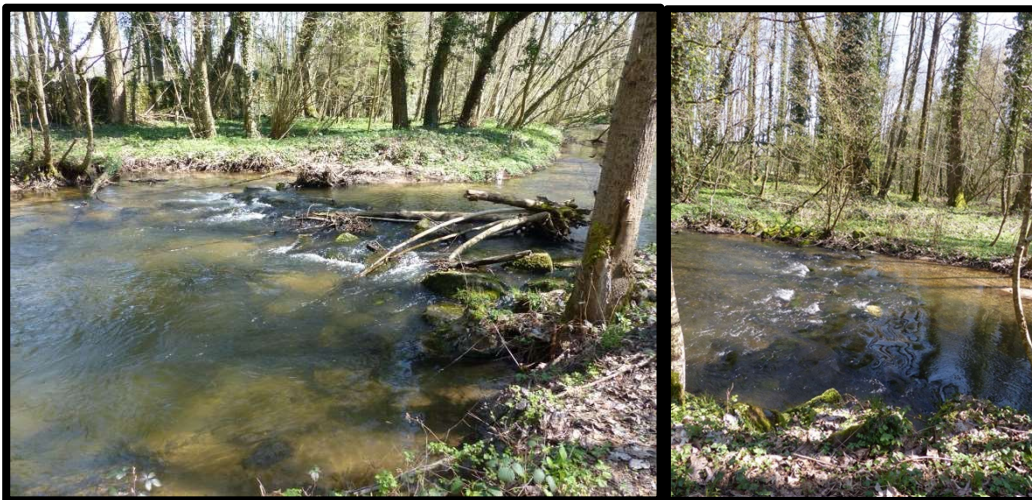
Photographie III-5 : Seuils de flottage sur la Vezouze. D. Mathis/2019
