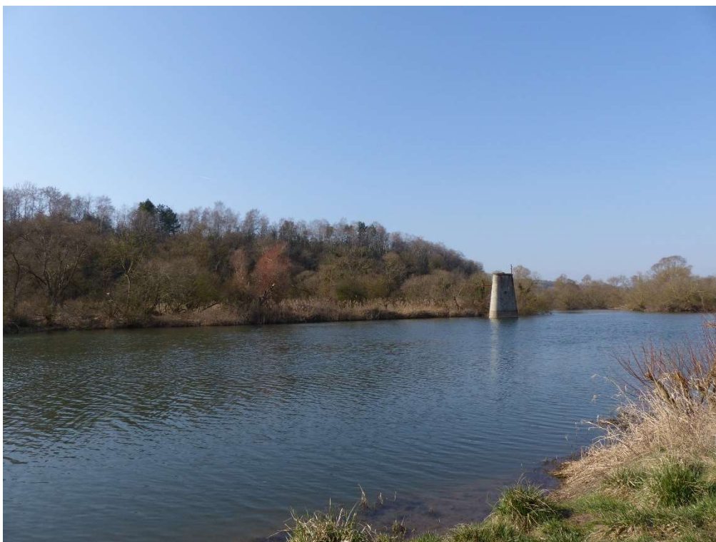
Photographie III-17 : La Meurthe entre les anciens bassins de décantation. Source photographie D. Mathis/2019.
