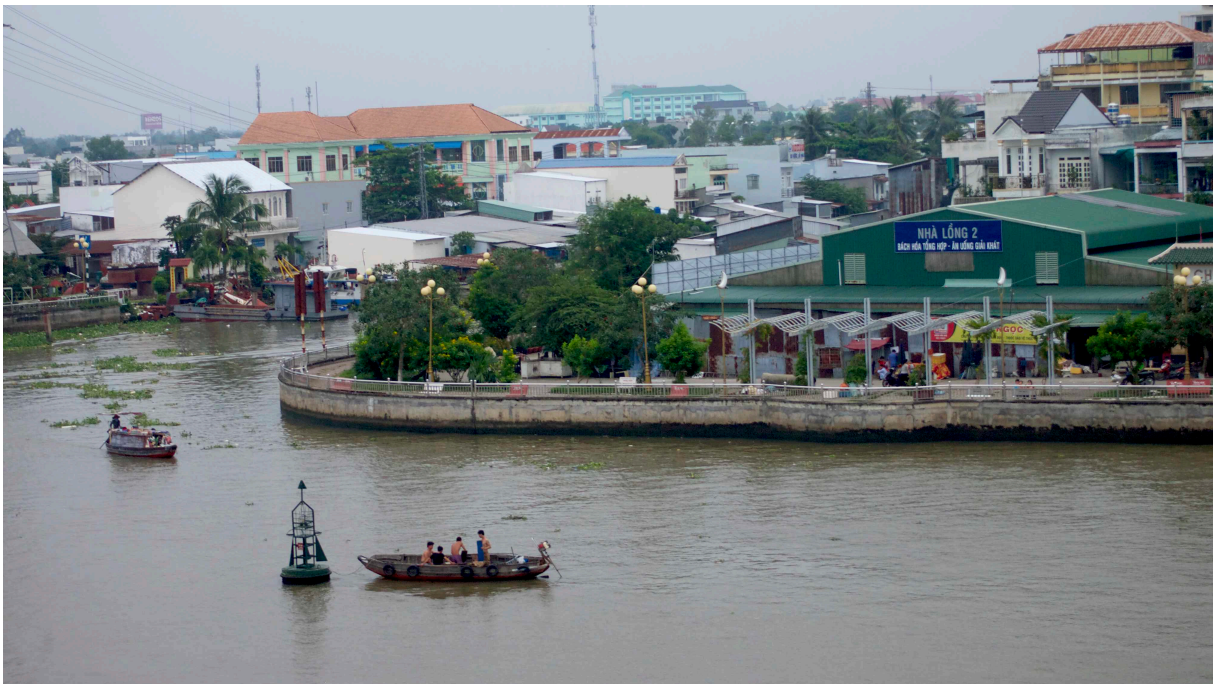
6. Endiguement des berges de la rivière Can Tho dans la périphérie sud-ouest de la municipalité de Can Tho, projet achevé financé par la Banque Mondiale (Clara Jullien, 11 novembre 2019, quartier Le Binh, district de Cai Rang, Municipalité de Can Tho)
