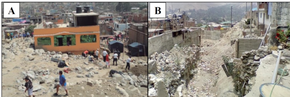
Illustration 3 - Dégâts lors des écoulements torrentiels récents
