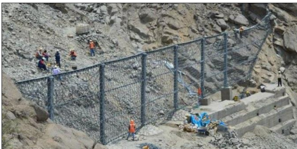
Illustration 12 - Barrière flexible n° 10 dans le ravin Carossio
