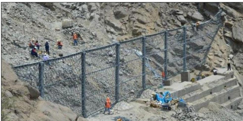
Barrière de type UX d'une longueur de 54 m avec six supports intermédiaires et une capacité d'impact de 180 kN/m<sup>2</sup>, la plus longue des 21 barrières installées à Chosica.
