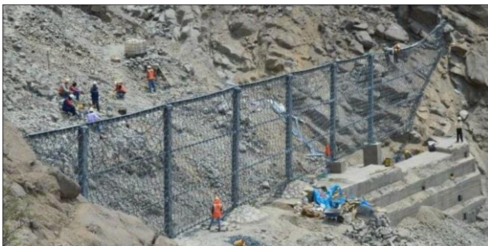
Illustration 12 - Barrière flexible n° 10 dans le ravin Carossio
