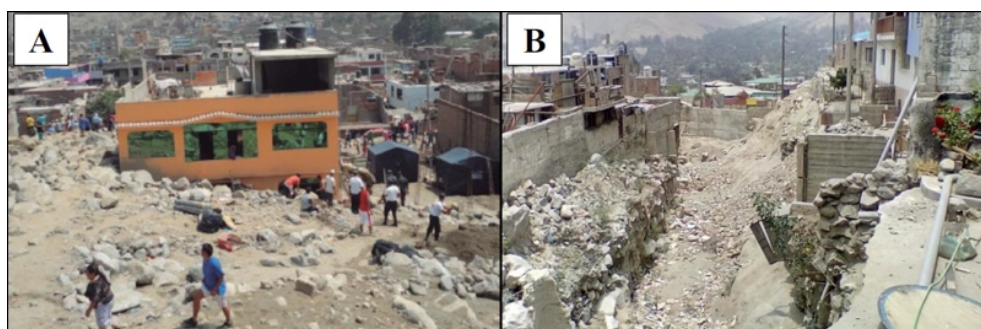
Illustration 3 - Dégâts lors des écoulements torrentiels récents
