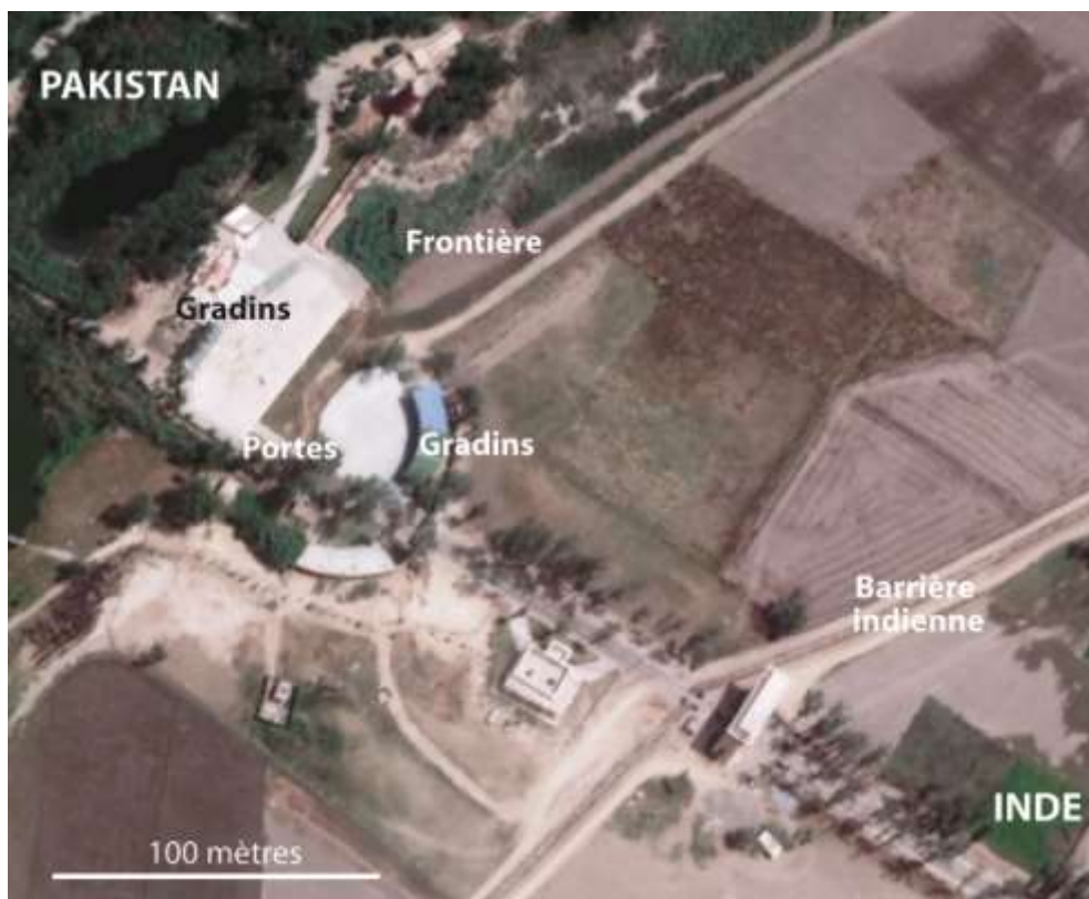
$974 Détail des infrastructures dédiées à la cérémonie de la fermeture de la clôture de la frontière à Sadiq
