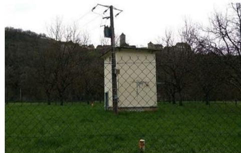
Site de captage de Montvalent
