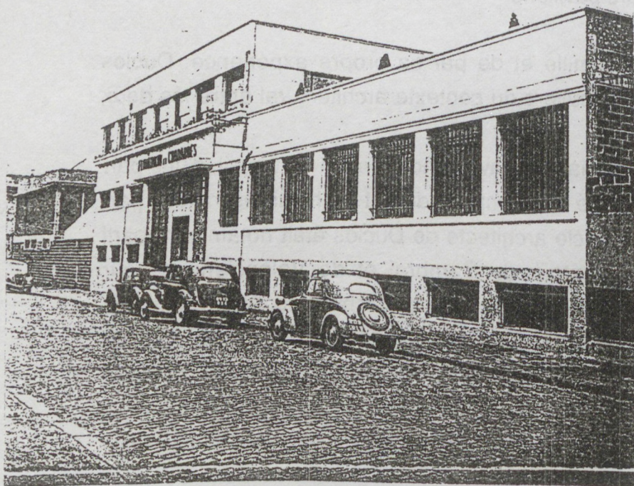
Usine de Pantin: Façade sur Rue.
