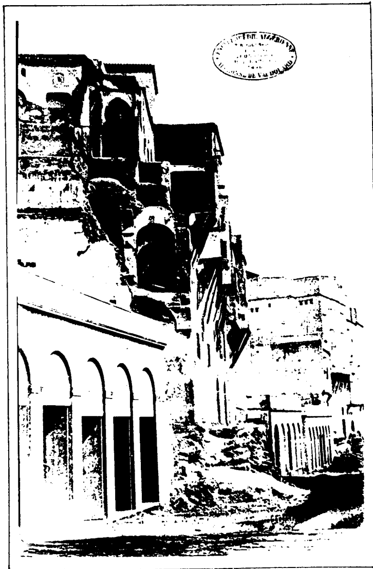
10- Travaux de percement de la rue Randon, photographie 1865, ANOM.
