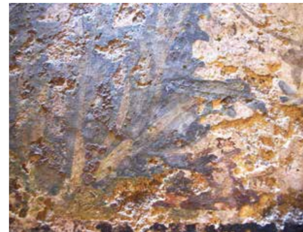
13. Cuma, mausoleo dei "girali d'acanto", lunetta ovest: particolare del cespo con in evidenza le tracce di lavorazione
