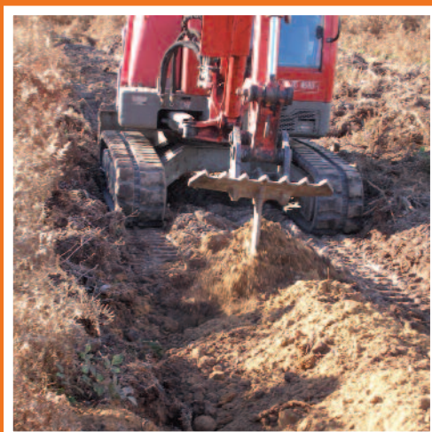
Réalisation avec minipelle et sous-soleur multifonction®
