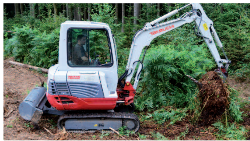
Présentation de l'engin avec tous les équipements : à l'arrière : sabot de franchissement® ; à l'avant : le scarificateur réversible®
