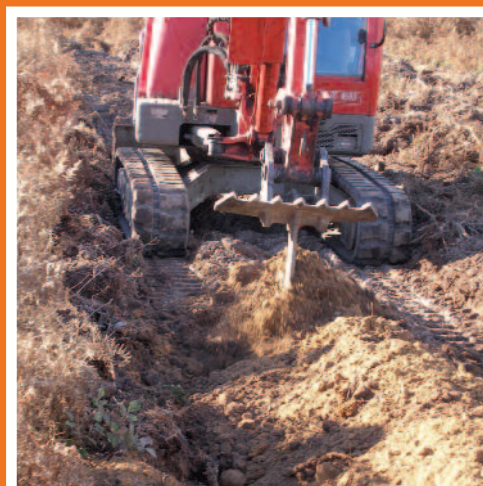
Réalisation avec minipelle et sous-soleur multifonction®
