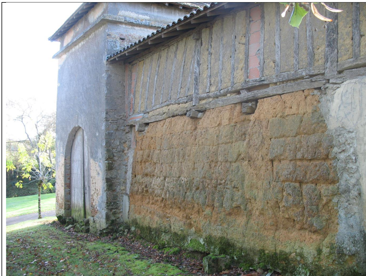
Fig. 11 : Photographie du mur en terre massive et de la porte visibles à l'extrémité nord de plate-forme du Castet, prise depuis le nord (cliché : N. Guinaudeau)
