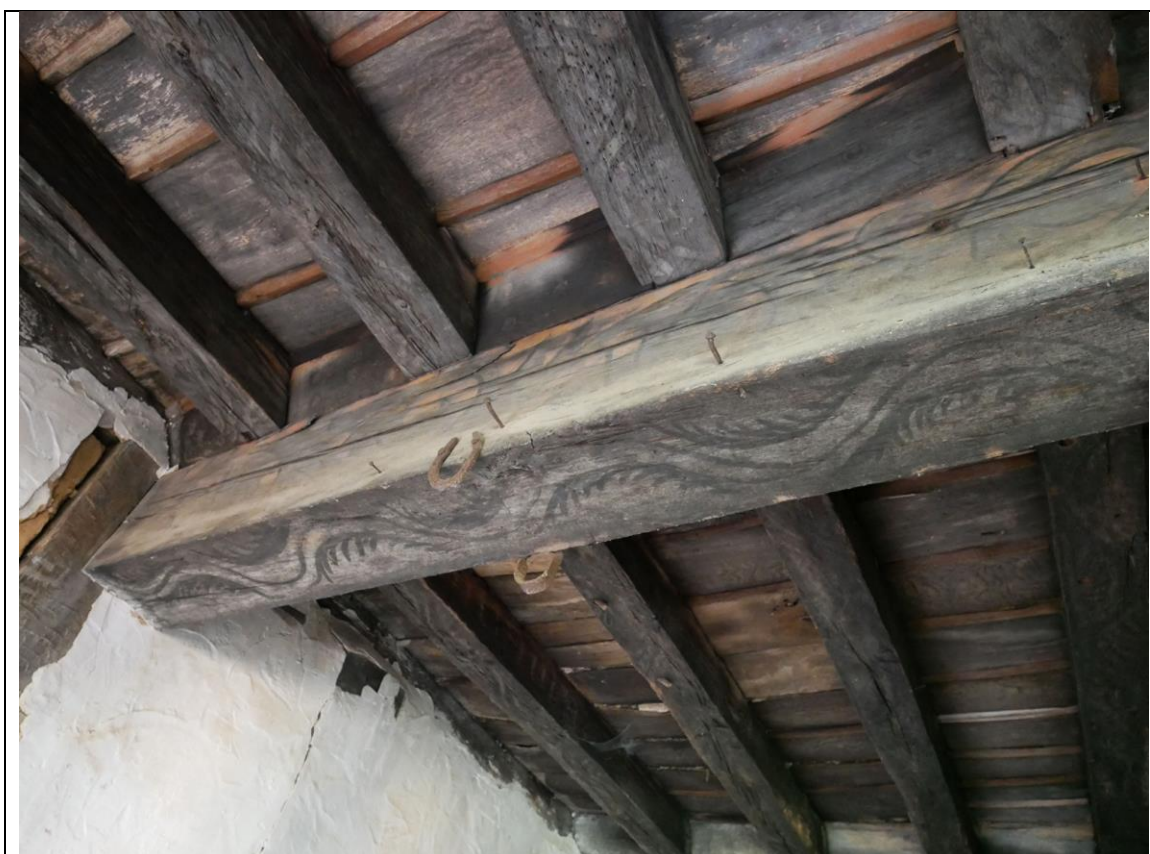
Fig. 15 : Photographie du plafond peint visible au rez-de-chaussée dans la cuisine (Cliché : N. Portet)
