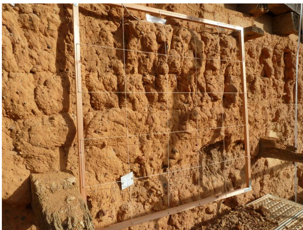
Fig. 23 : relevé de façade au carroyage de 1 x 1 m
