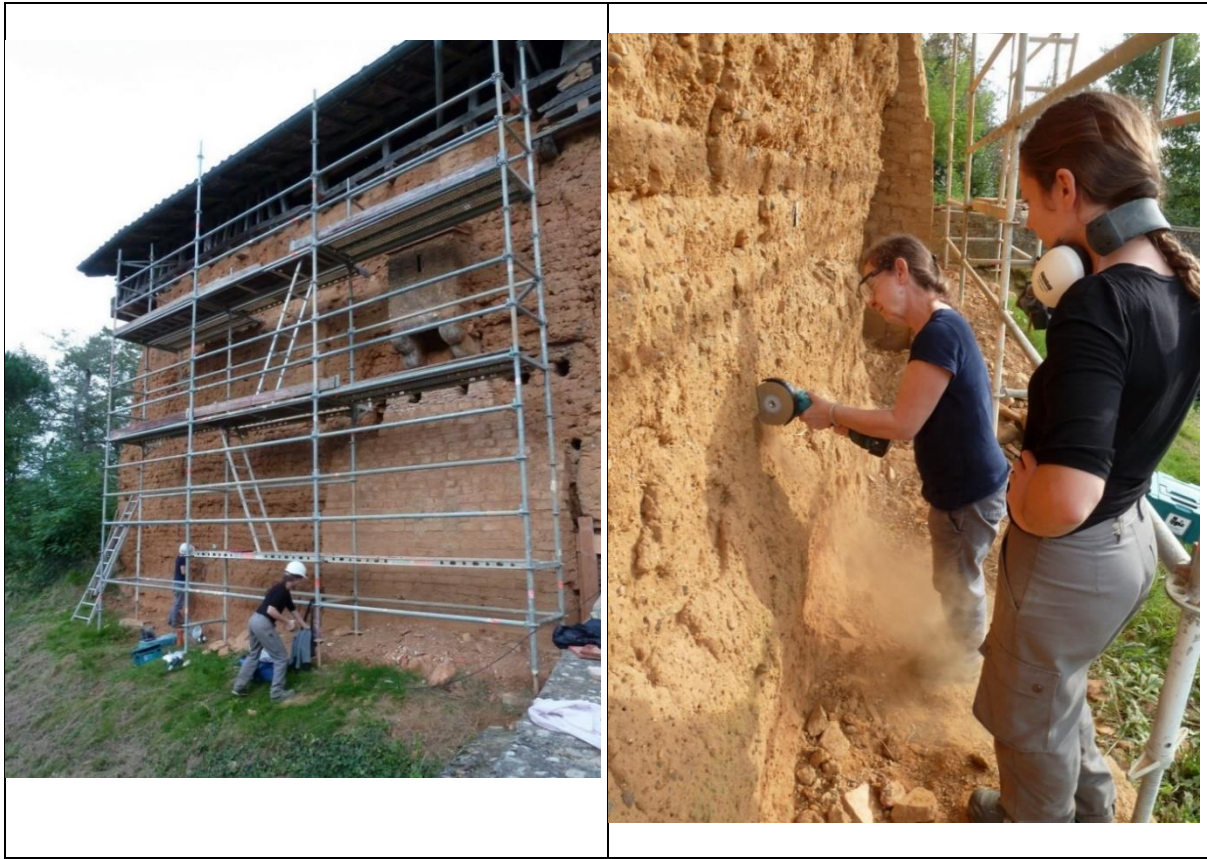
Fig. 21 : Vue de l'échafaudage, contre le rempart ; Prélèvement à la disceuse
