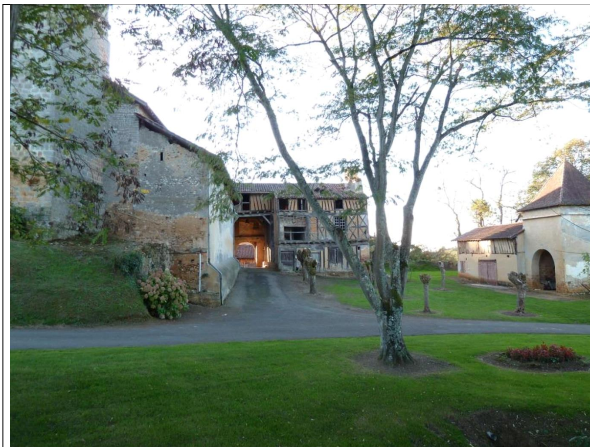
Fig. 12 : Vue de la cour et de la façade est du logis (cliché : A. Klein)
