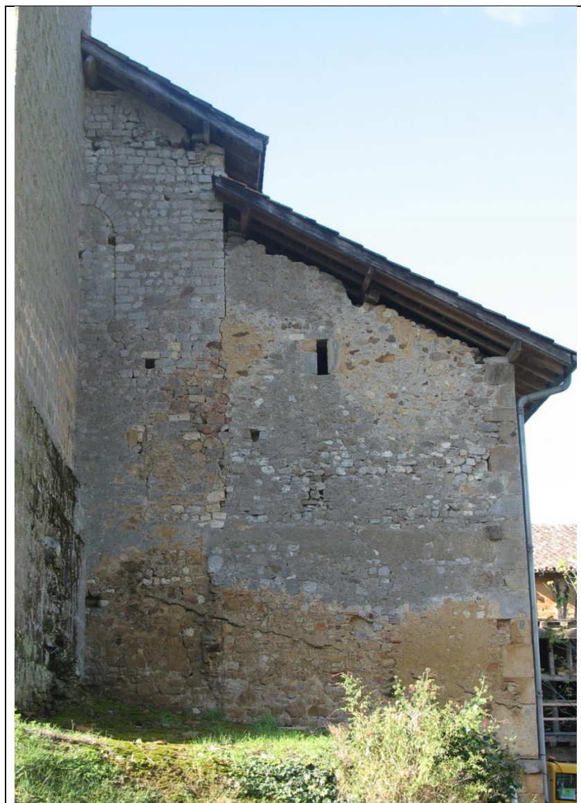
Fig. 16 : vue de la partie nord du chevet (MUR 213) et sa fenêtre (FEN 205) bouchée
