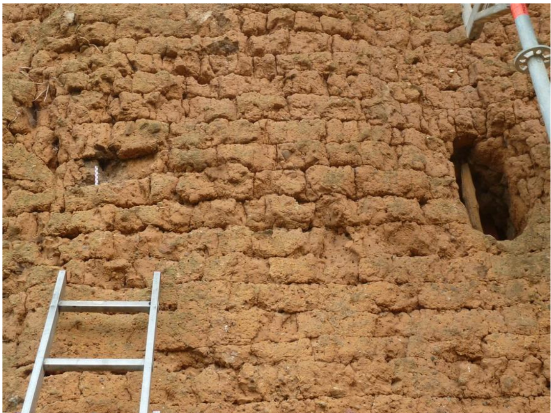
Fig. 22 : vue du rempart après prélèvement P1 (au-dessus de l'échelle)
