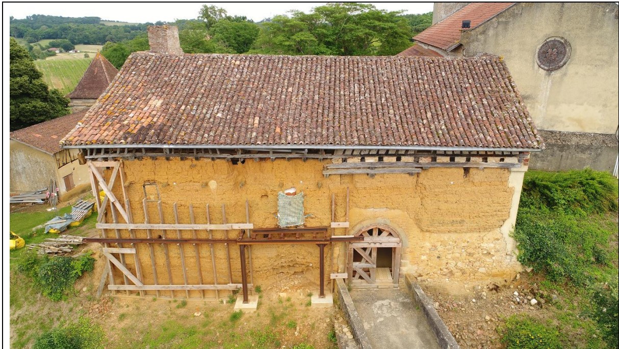
Fig. 10 : Photographie du rempart en terre massive préservé en limite occidentale de la plate-forme du Castet, prise depuis l'ouest (cliché par drone : S. Durand)
