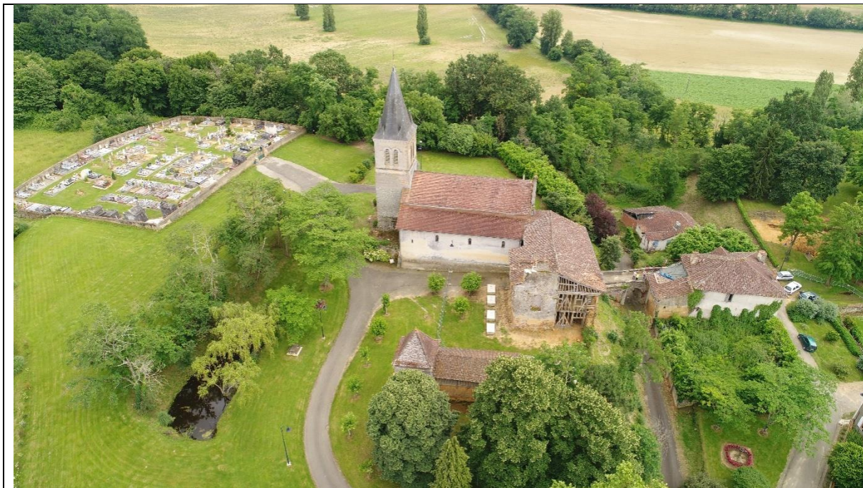
Fig. 6: Vue par drone du castet en direction du sud (de gauche à droite, cimetière actuel, église, logis à pan de bois, fossé et pont (chemin communal), presbytère) (Sylvain Durand).
