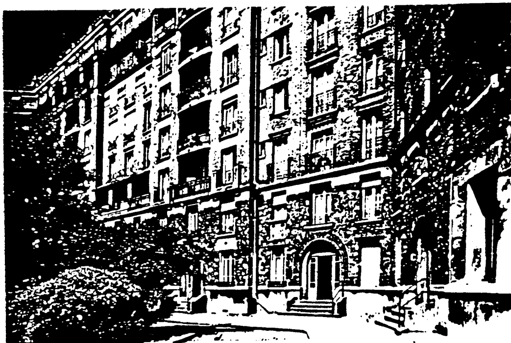
Façade sur la cour-jardin d'un des Immeubles rues Boyer, d'Annam et de la Bidassoa (1913 et 1914)
