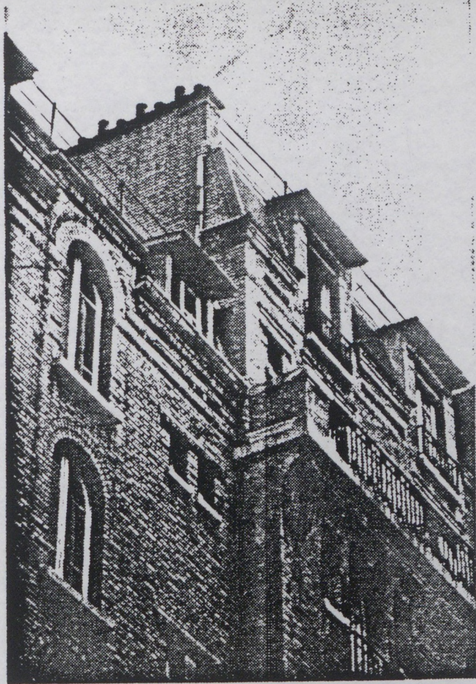
Différence de niveaux entre le retour de l'immeuble de l'avenue Daumesnil et celui de la rue du Congo
