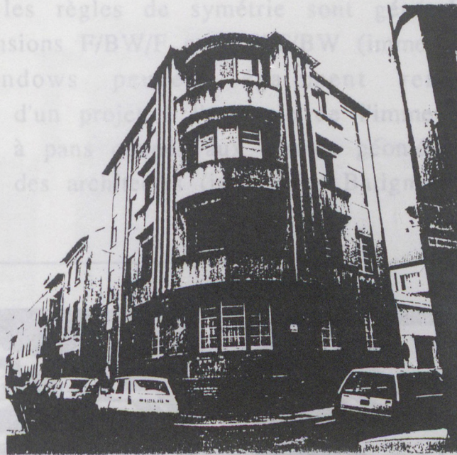
Fig.(57): Immeuble Bertoluzzi, arch.: Munvez, 1938
