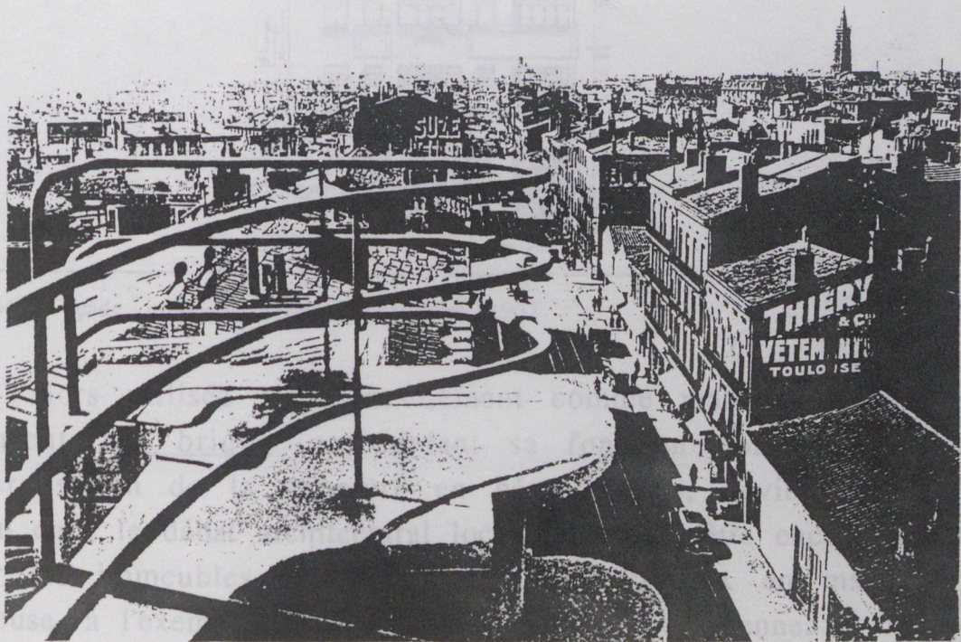
Fig.(63): Vue des toits de Toulouse en 1930 depuis une "terrasse fleurie"
