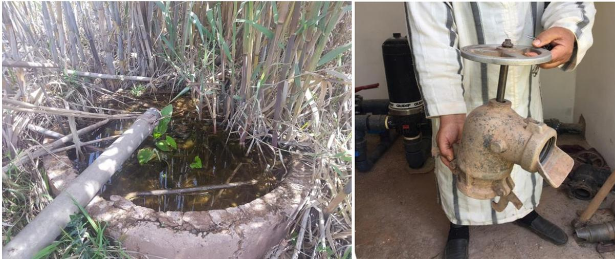
Figure 12. Borne et conduite utilisées pour l'irrigation en gravitaire et remise en service (à gauche) et dispositif utilisé pour brancher les nouvelles installations sur la borne (à droite) (photo prise le 16/04/2019)
