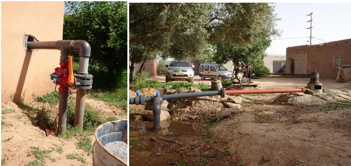
Figure 19. Interconnexion du forage avec le réseau collectif, avec des vannes permettant de choisir la ressource distribuée sur la parcelle
