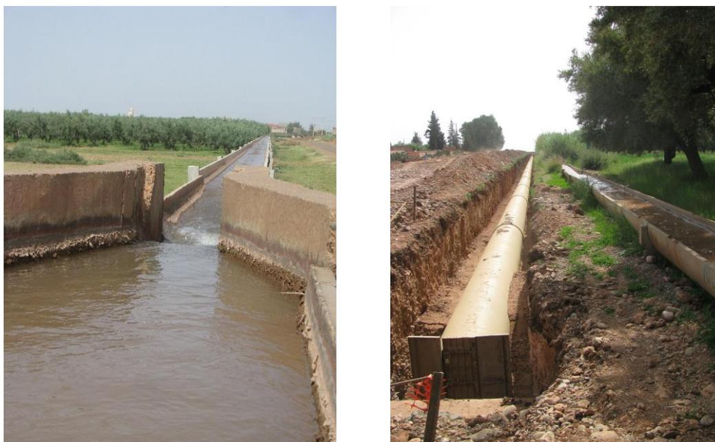
*Figure 1. Canal d'amenée de l'eau en gravitaire (gauche) et modernisation du réseau d'amenée (droite) avec la création d'un système de canalisations sous pression enterrées. Périmètre du Tensift. Maroc.*
