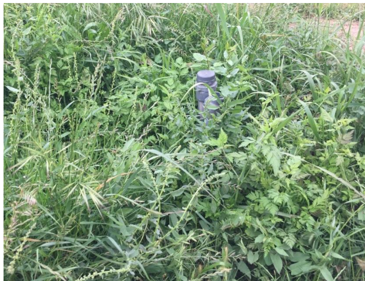
Figure 11. Purge ouverte pour l'irrigation en gravitaire (photo prise le 23/04/2019)
