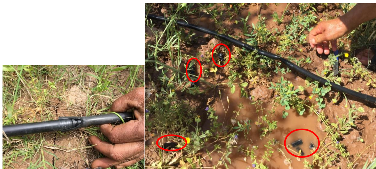
Figure 9. Rampe réparée (gauche) et parties coupées (rouge) d'une rampe réparée à plusieurs reprises (droite)
