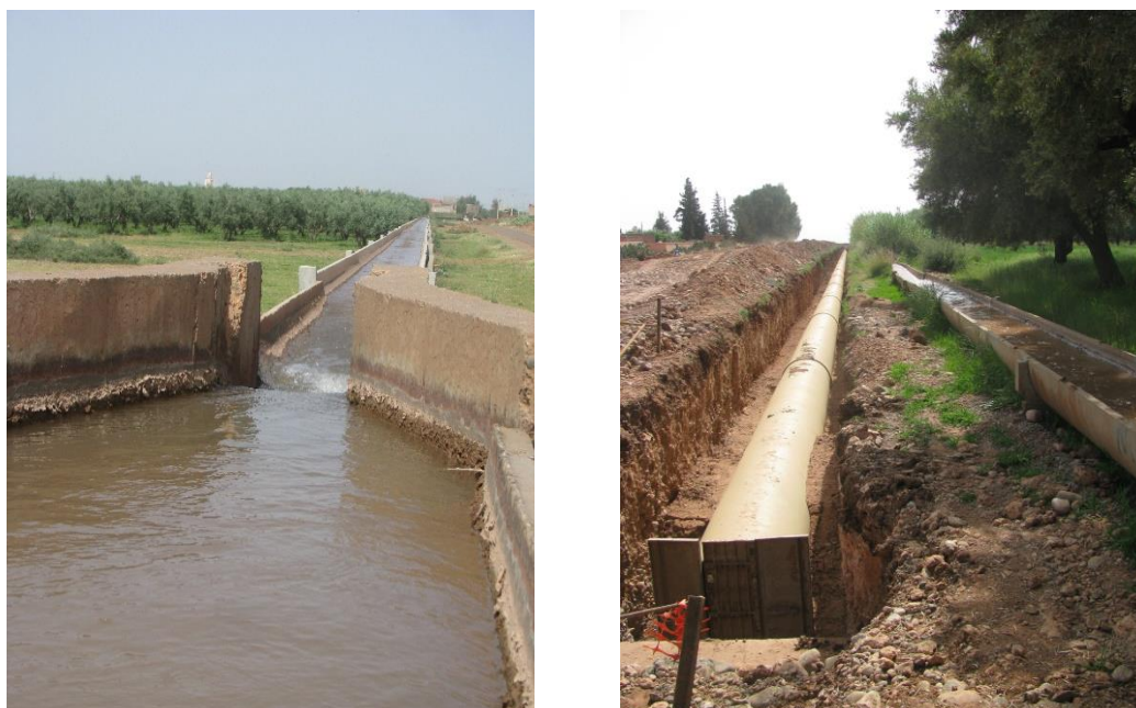
Figure 1. Canal d'amenée de l'eau en gravitaire (gauche) et modernisation du réseau d'amenée (droite) avec la création d'un système de canalisations sous pression enterrées. Périmètre du Tensift. Maroc.
