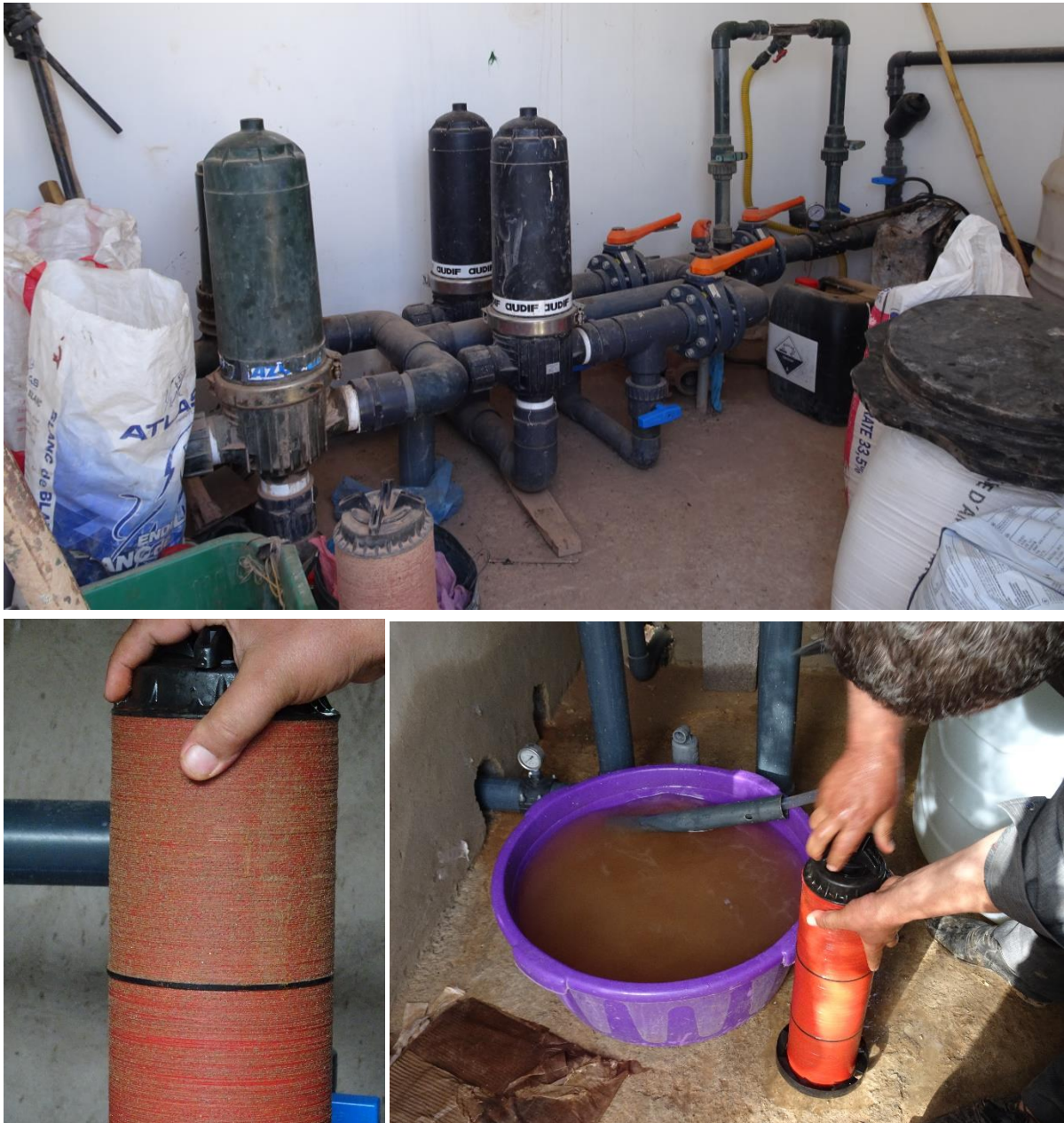
Figure 22. Des eaux parfois trop chargées, conduisant à des problèmes de filtration et incitant les agriculteurs à se tourner vers des ressources filtrées naturellement (eaux souterraines)
