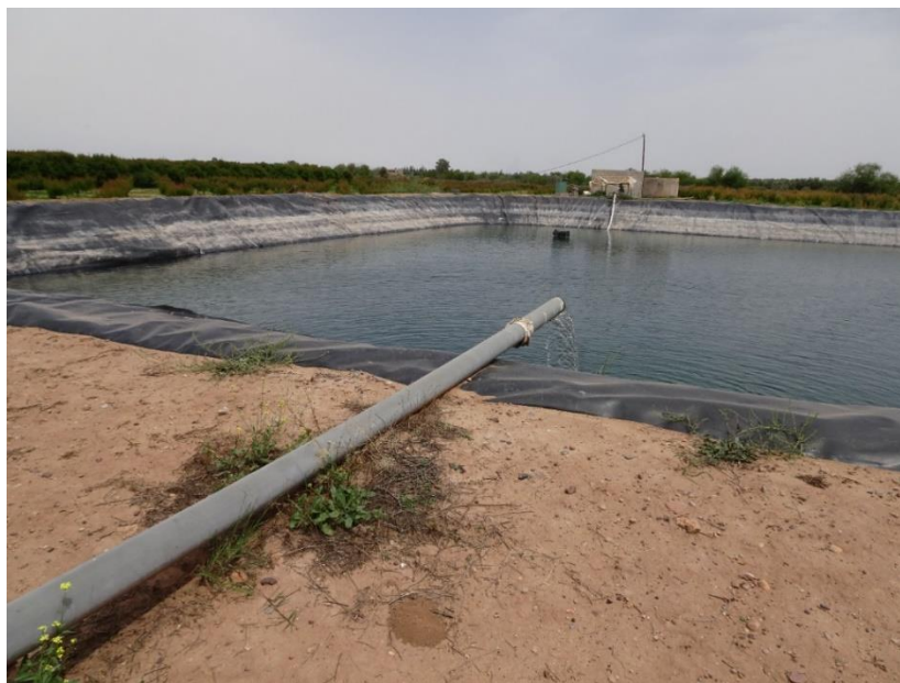
Figure 21. Réservoir de stockage chez l'agriculteur, recevant les différentes eaux (Office et eau souterraine), mise ensuite dans le réseau en goutte-à-goutte
