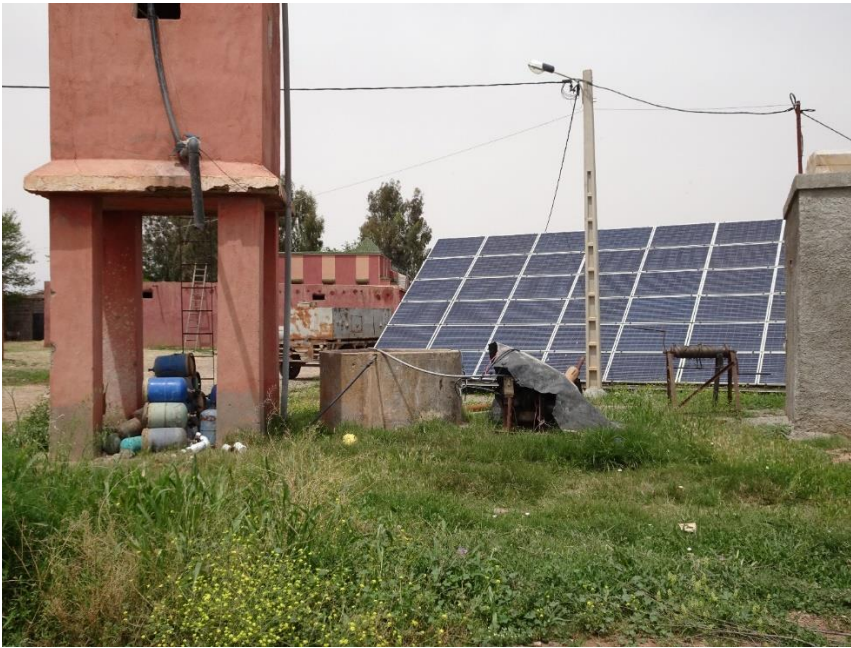
Figure 24. Investissement dans des panneaux solaires pour satisfaire les besoins d'énergie (notamment liés au pompage de l'eau souterraine) avec le gaz comme ressource d'appoint
