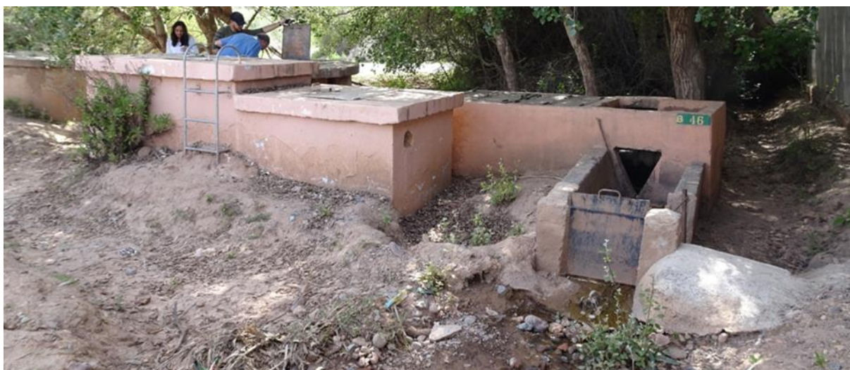
Figure 7. Coexistence d'anciennes prises en gravitaire avec les nouvelles sous pression
