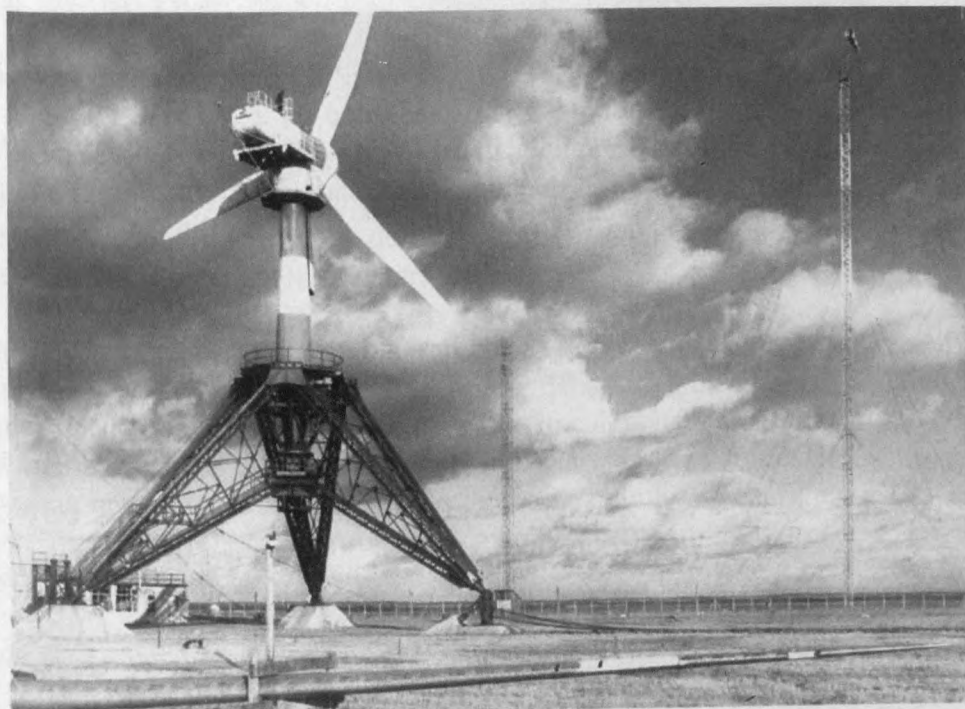
-la machine Vadot-Neyrpic (Saint-Remy des Landes, Manche, France, 1963), puissance installée 1000kW, pales à pas variable en résine synthétique armée.
