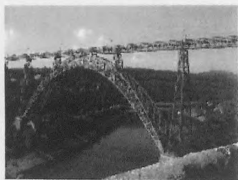
fig. 22. Viaduc du Garabit (source : internet)
