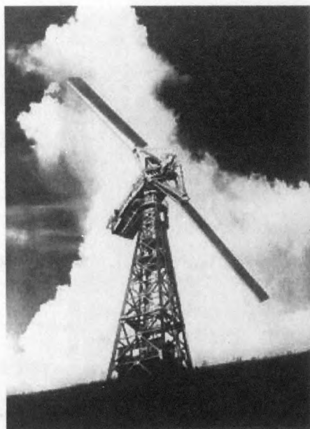
-la machine Best-Romani (Nogent-le-roi, Eure-et-Loir, France, 1959), puissance installée 1000kW (Romani dit avoir pris une marge de sécurité trop forte en annonçant 800kW...), pales fixes en alliage d'aluminium-zinc,
