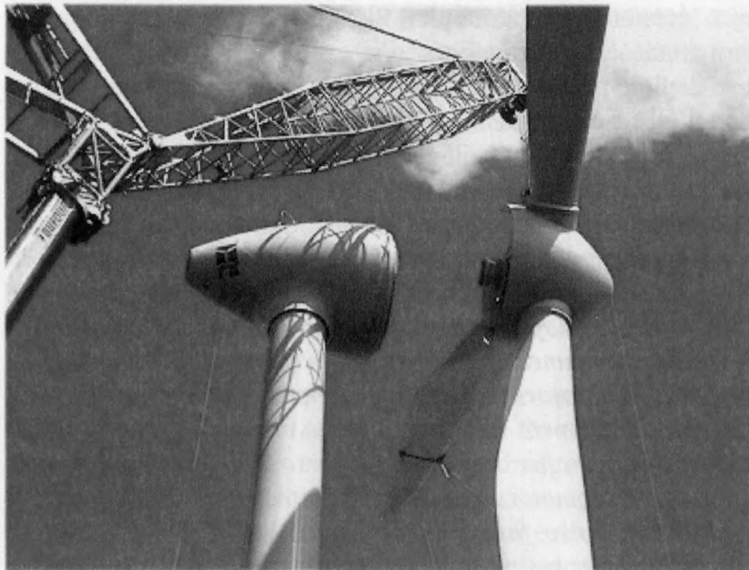
Construction d'une éolienne, Plouguin
