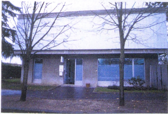
Chambre mortuaire, vue extérieure
