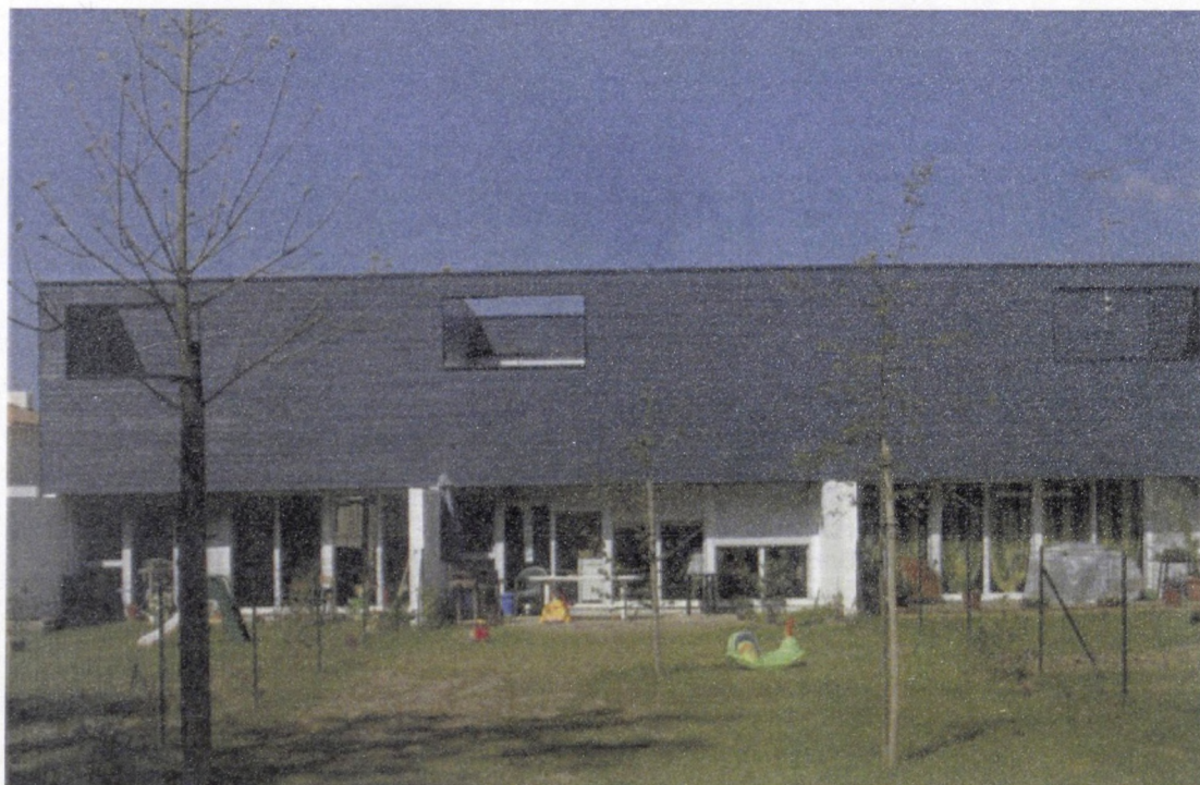
Fig. 82 Opération Rex-Pirotterie, la maison Nu (ACC Stalker). Source : AMC
