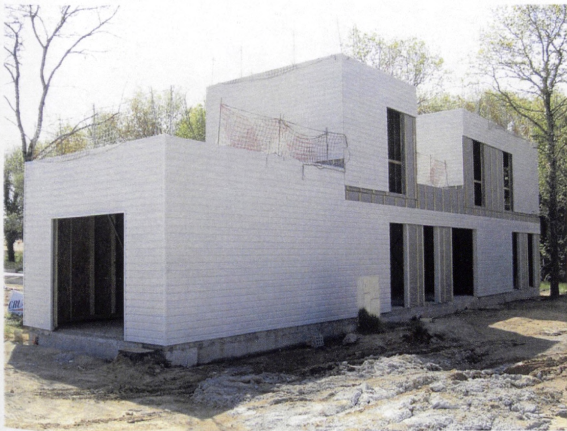
Fig. 35 Opération Rex-Piroterrie, la maison M'House (Actar Architectura). Source : R. Picaper
