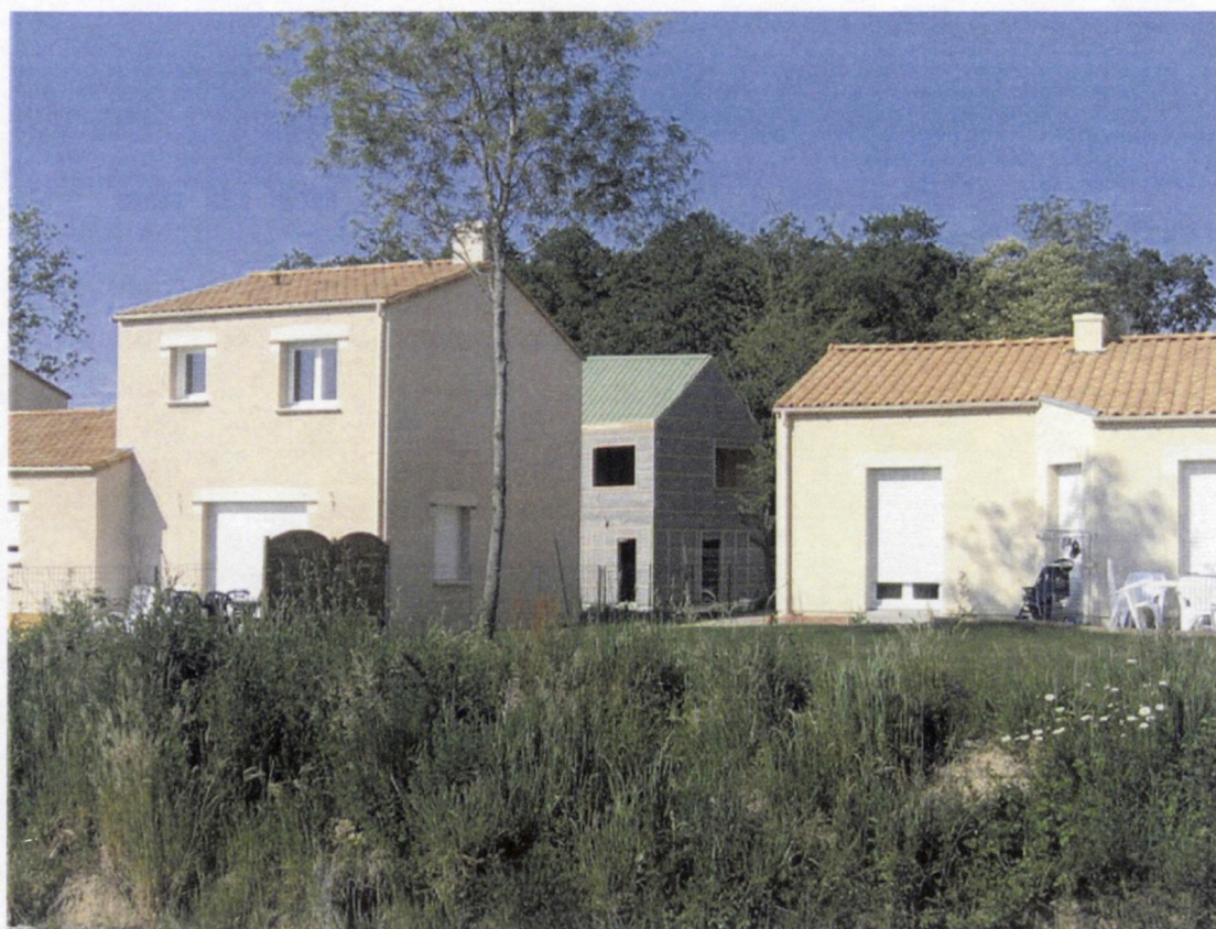
Fig. 56 Opération Rex-Piroterie, vue extérieure. En travaux, la Maison icône (Jumeau + Paillard) Source : R. Picaper
