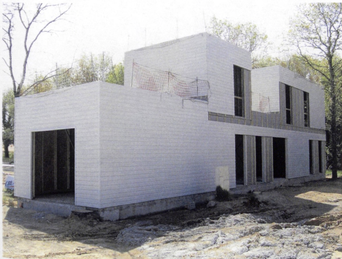
Fig. 35 Opération Rex-Piroterrie, la maison M'House (Actar Architectura). Source : R. Picaper
