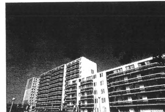
La route des châteaux, Noisy-le-Grand arch. inconnu , SCIC 1978
